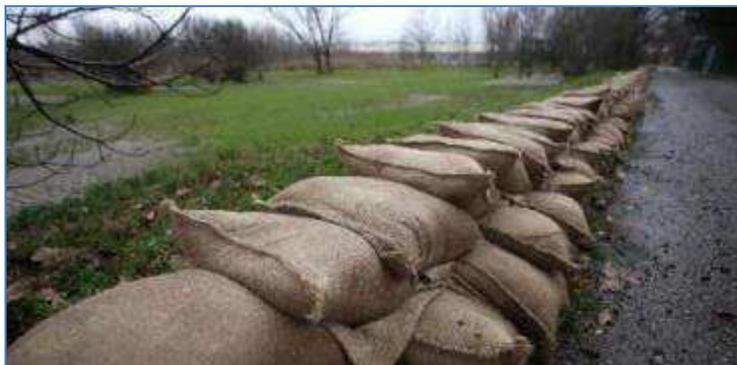
Figura 5.4 – Barriera temporanea antiesondazione in sacchi di sabbia
