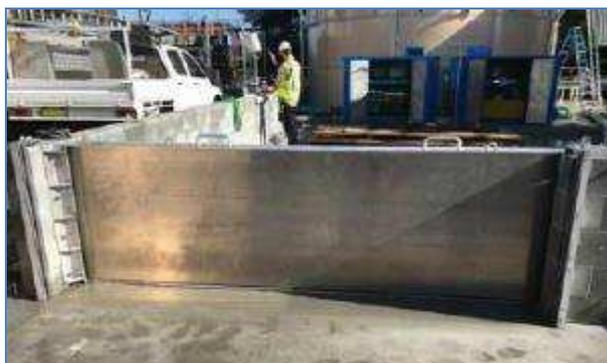
Figura 5.10 – Paratoia di chiusura a scorrimento orizzontale per un cancello a tenuta idraulica
