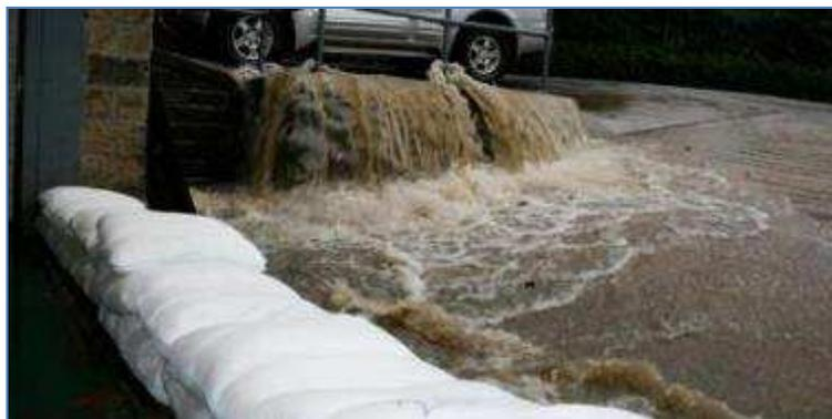
Figura 5.5 – Barriera temporanea in sacchi riempiti con materiale sintetico assorbente
