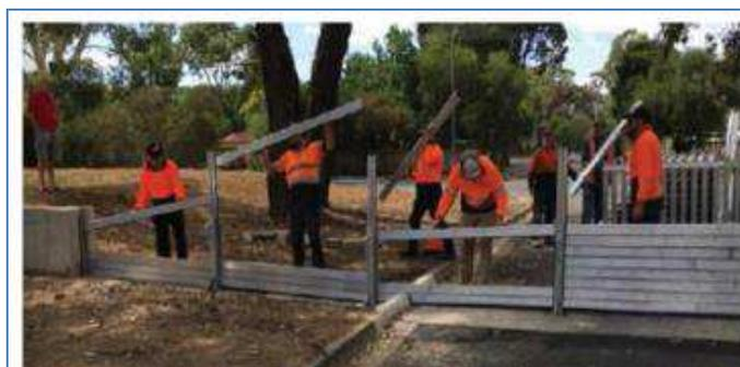
Figura 5.9 – Barriera temporanea modulare con pilastri e panconi manuali in alluminio
