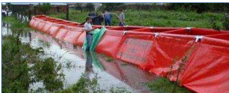
Figura 5.7 – Barriera temporanea antiesondazione riempita ad acqua
