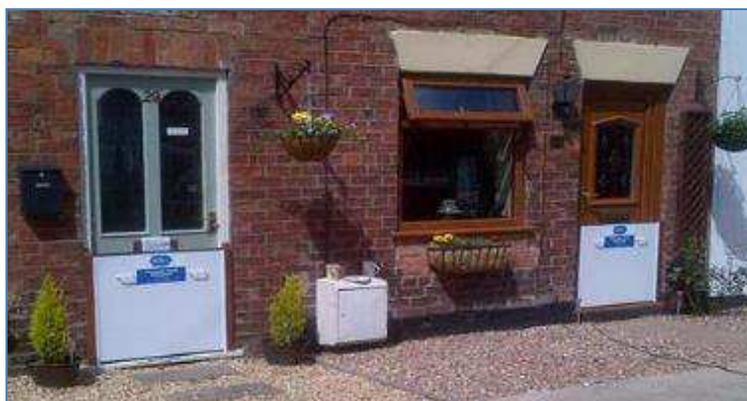
Figura 5.11 – Paratoie manuali a protezione di porte di ingresso
