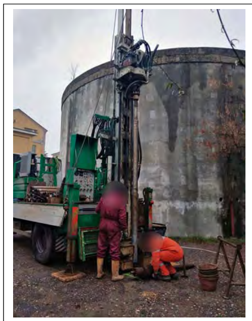
Sondaggio S.3 c/o "ex Depuratore"
