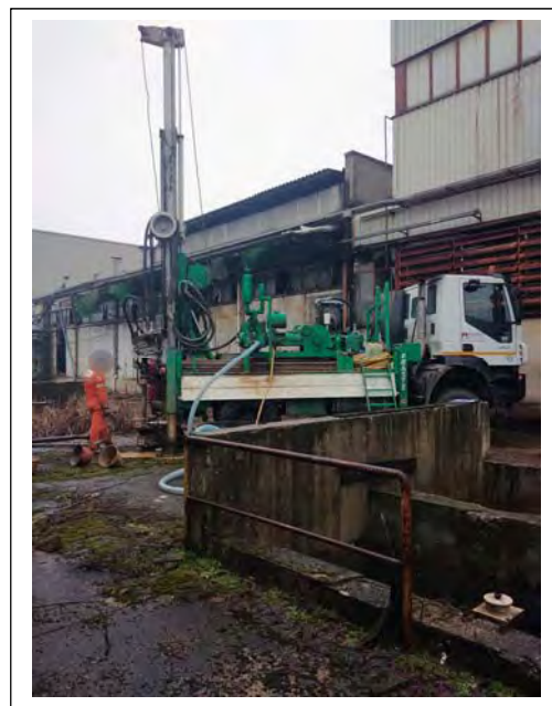
Sondaggio S.2 c/o "ex Necchi Sud"
