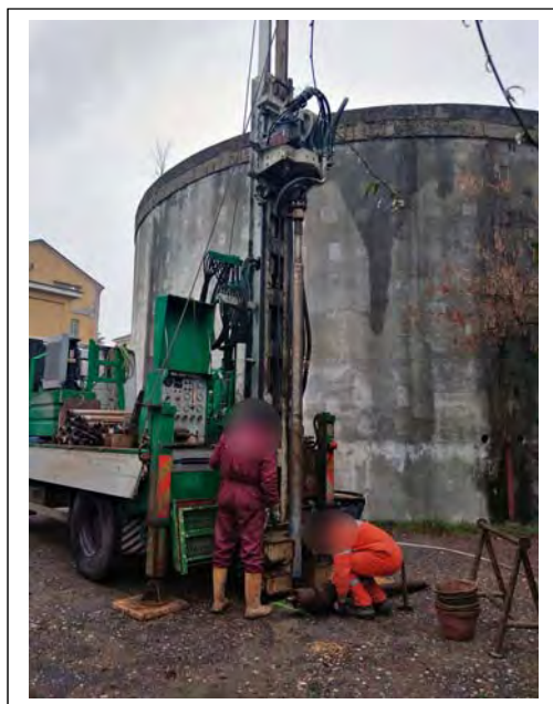
Sondaggio S.3 c/o “ex Depuratore”
