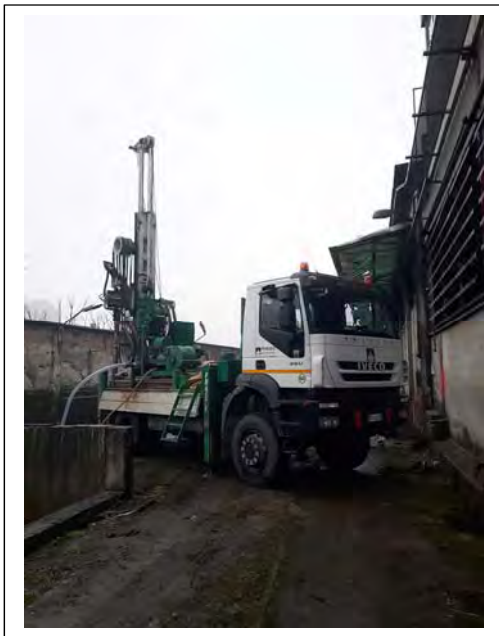
Sondaggio S.1 c/o "ex Necchi Sud"
