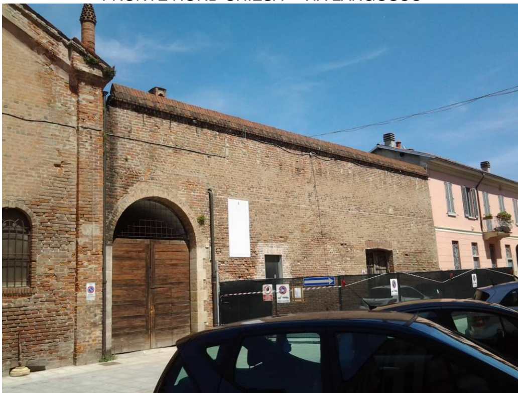
FRONTE NORD VIA LANGOSCO
