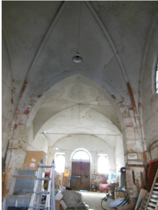
LOCALE T41 (CHIESA)
