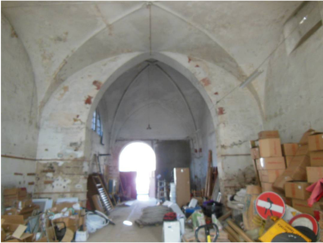
LOCALE T41 (CHIESA)
