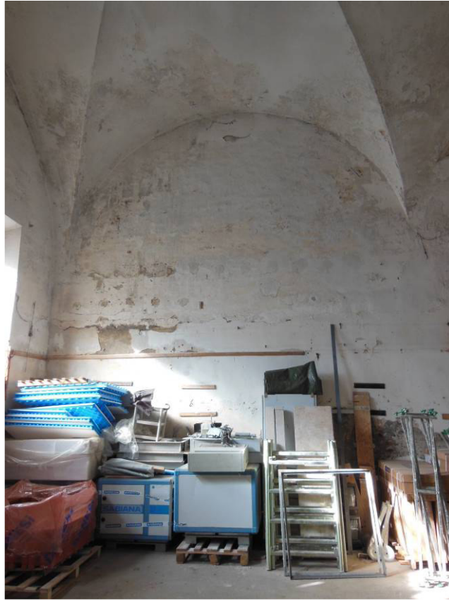
LOCALE T41 (CHIESA)
