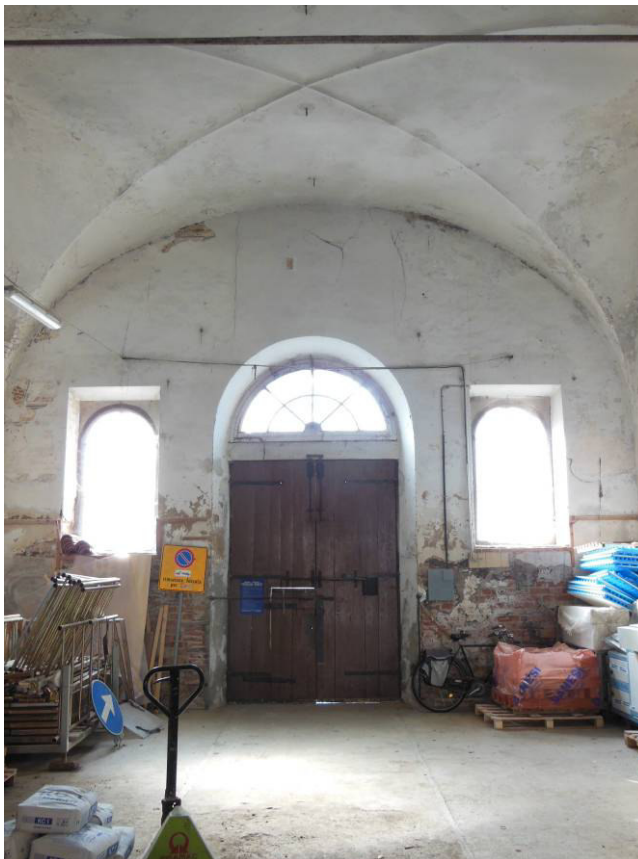
LOCALE T41 (CHIESA)
