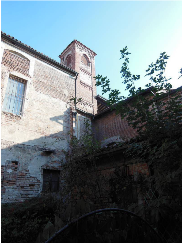
PROSPETTO NORD VERSO CORTILE PRIVATO
