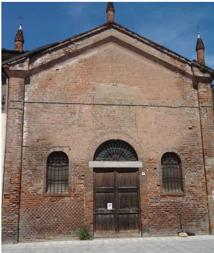
FRONTE NORD CHIESA – VIA LANGOSCO
