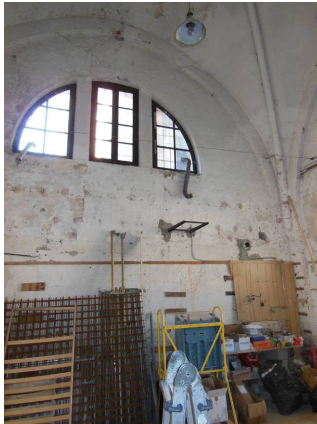
LOCALE T41 (CHIESA)
