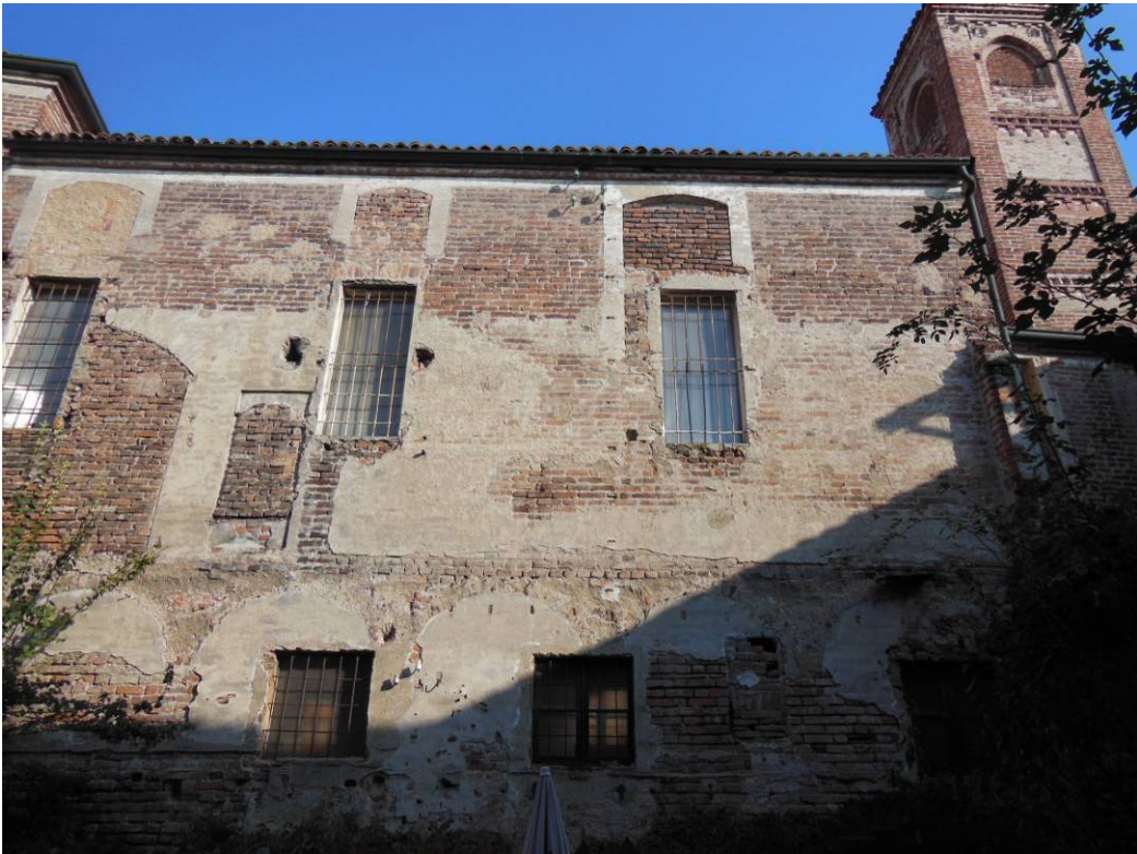
PROSPETTO NORD VERSO CORTILE PRIVATO
