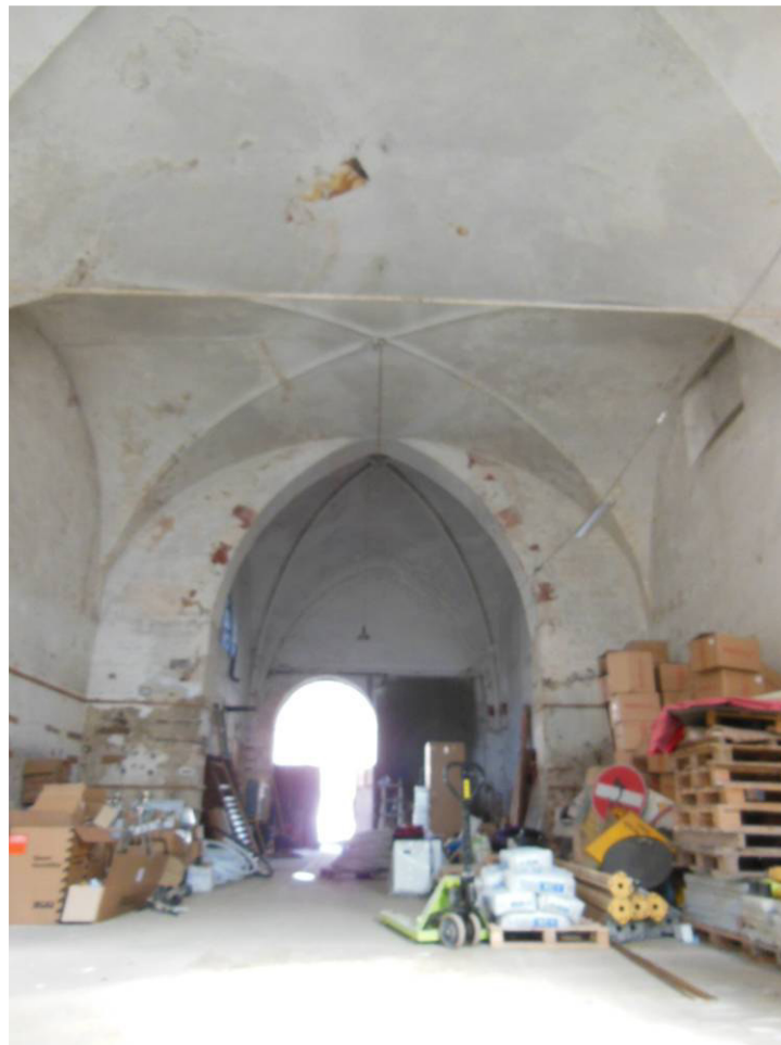
LOCALE T41 (CHIESA)
