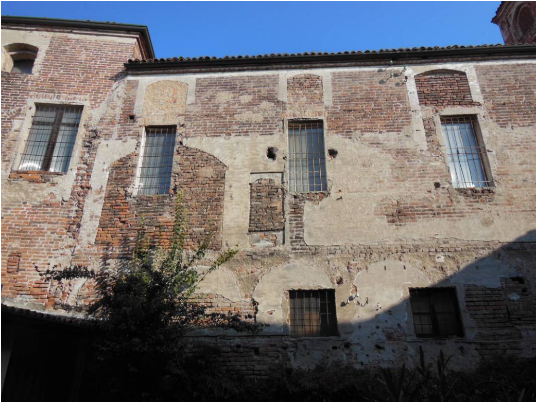
PROSPETTO NORD VERSO CORTILE PRIVATO
