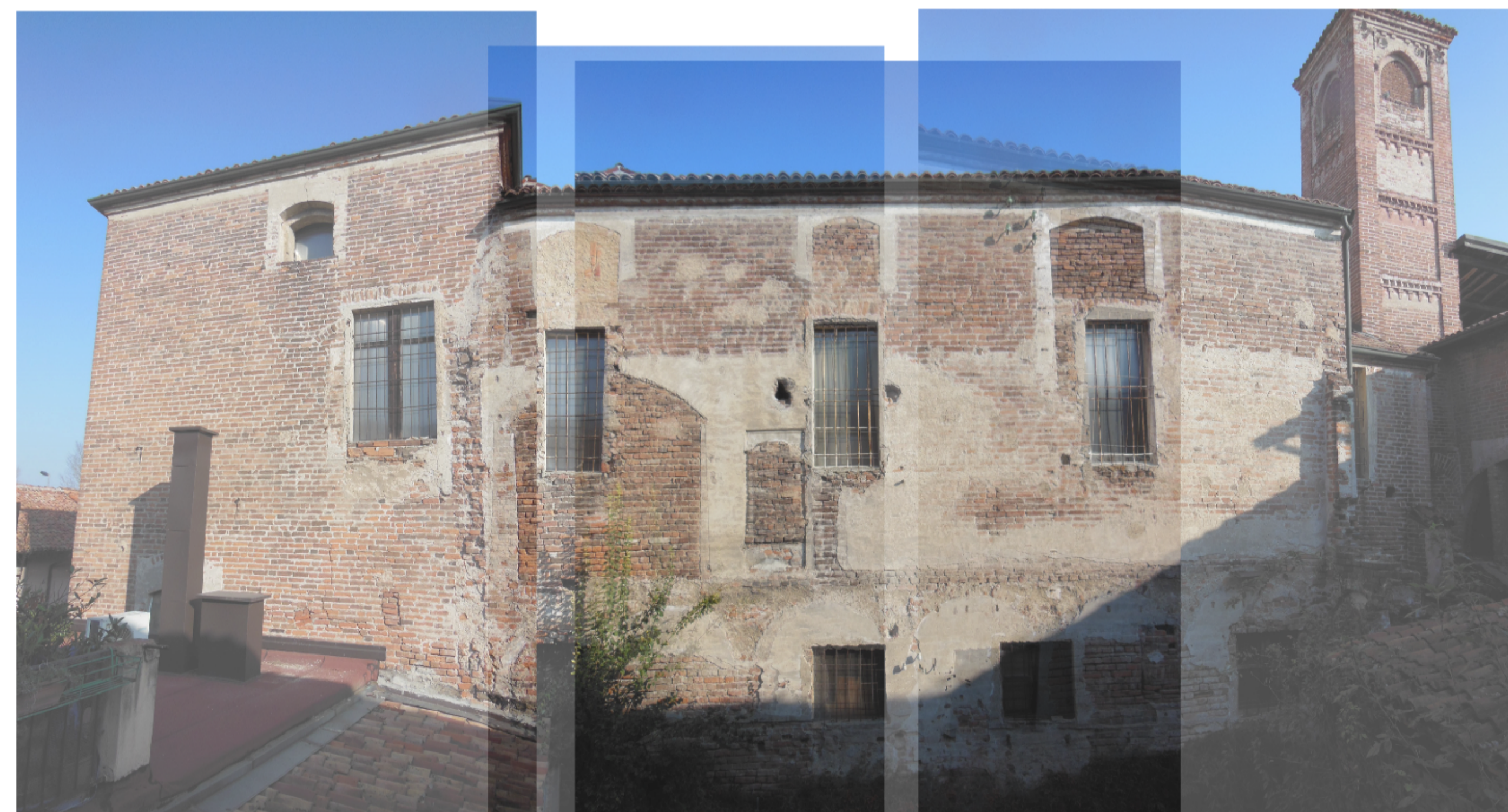
PARTICOLARI FOTOGRAFICI MURATURE MONASTERO
