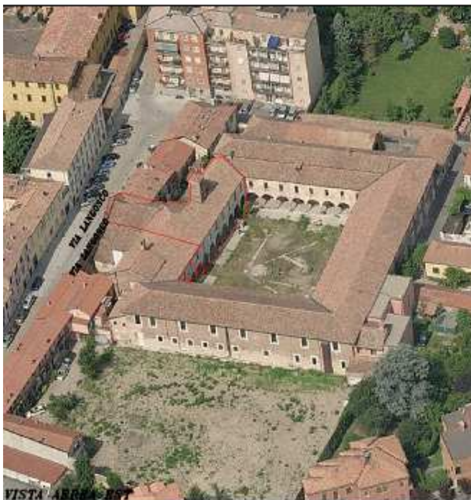
Viste aeree dell' complesso monumentale con individuazione delle zone oggetto di intervento
