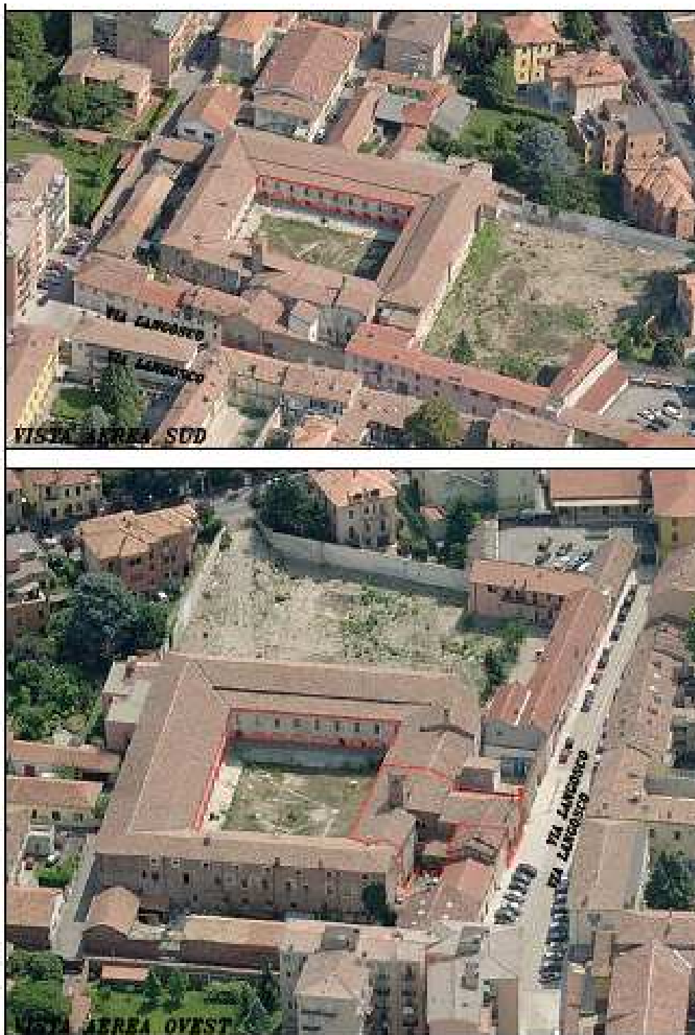
Viste aeree dell' complesso monumentale con individuazione delle zone oggetto di intervento
