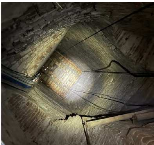
Vista all'intradosso del solaio ligneo a quota 16,20 m e solaio metallo/laterizio a quota 32,90 m.
