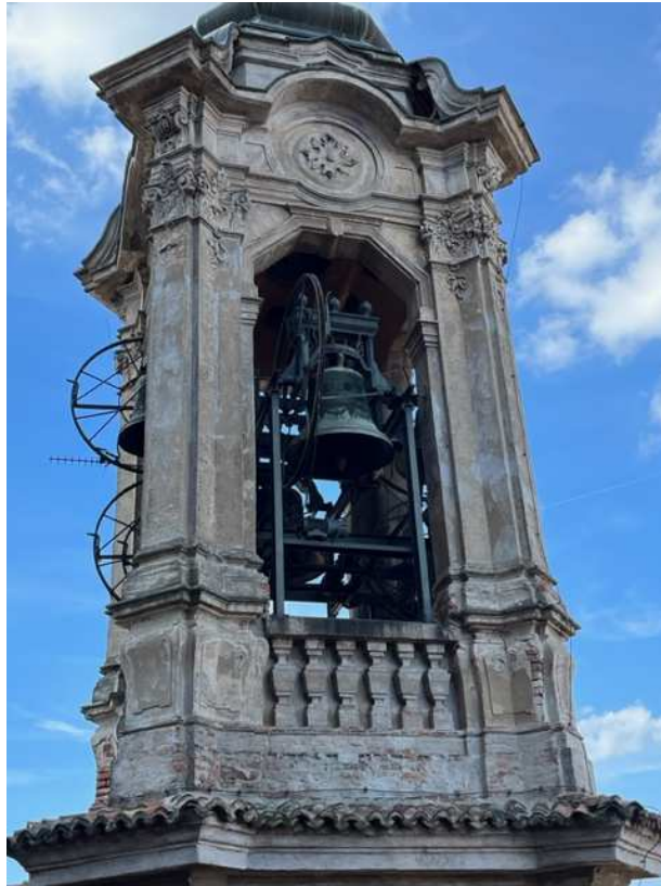
Vista della cella campanaria.
