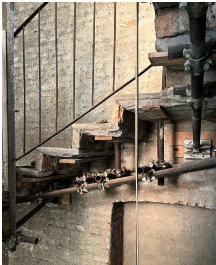
Vista interna: scala messa in sicurezza con puntelli metallici
