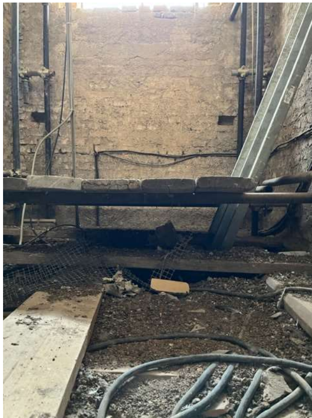
Fotografia n. 20 Vista interna: estradosso del secondo solaio ligneo a quota +16,20 m
