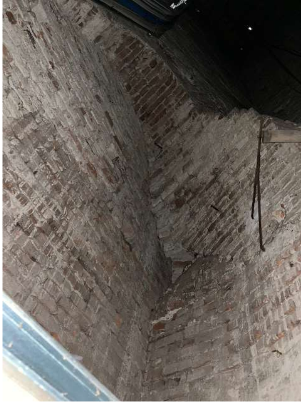
Fotografia n. 17 Vista interna del campanile: dettaglio arco in lato sinistro (lato est)
