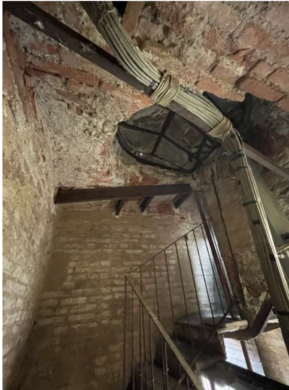
Fotografia n. 29 Vista interna: ultima rampa scale di accesso alla cella campanaria
