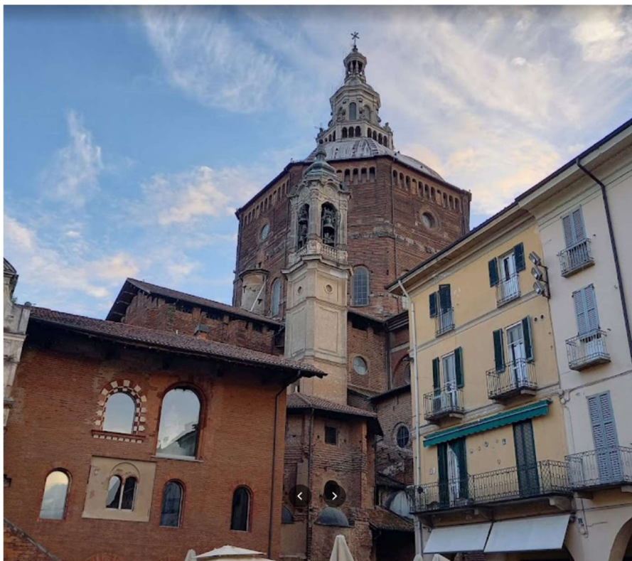
Fotografia n. 3 Vista del prospetto nord del campanile.
