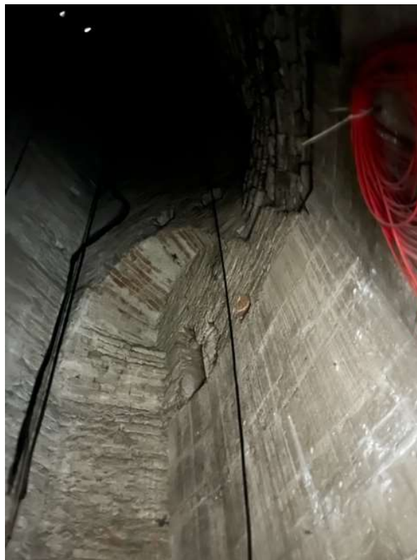
Fotografia n. 18 Vista interna del campanile: dettaglio arco in lato destro (lato ovest)
