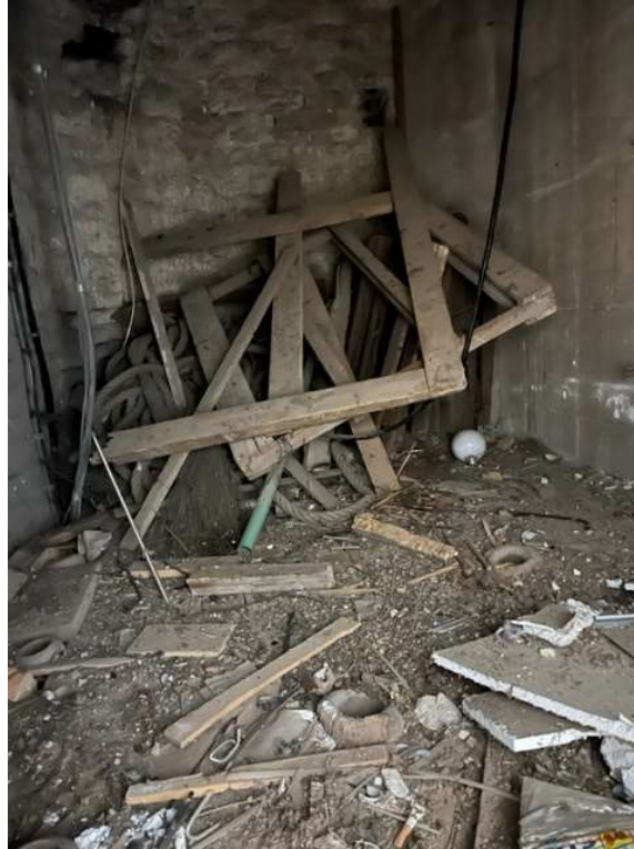
Fotografia n. 15 - Vista interna: primo orizzontamento ligneo a quota + 4,55 m
