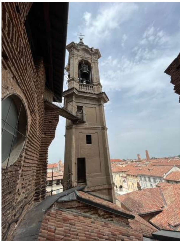
Fotografia n. 5 Vista del prospetto sud del campanile.
