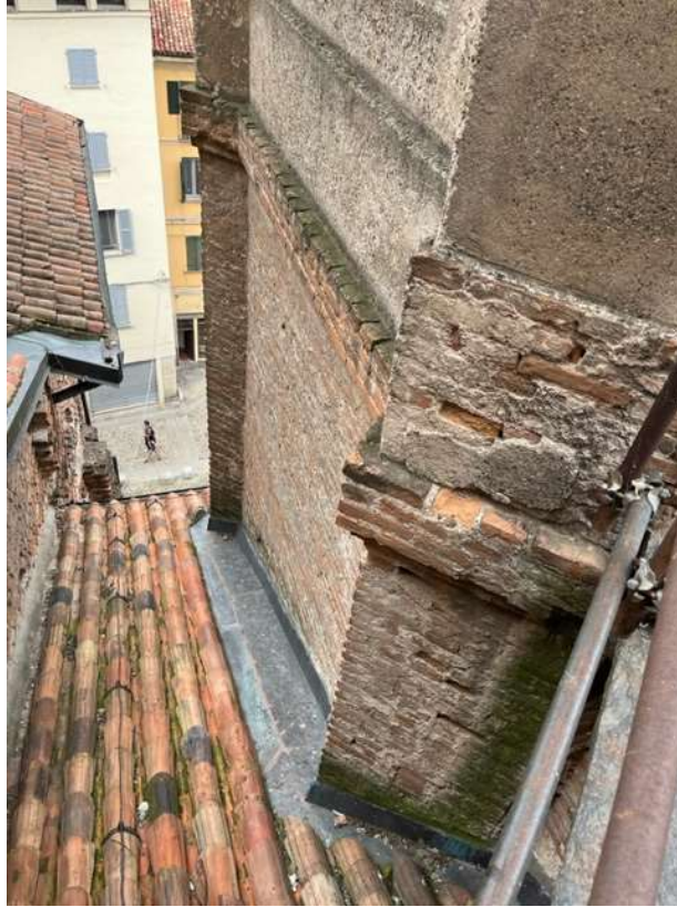
Fotografia n. 7 Evidenti fenomeni di decoesione e distacco del materiale in laterizio
