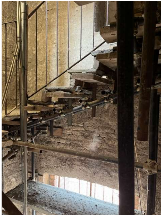
Fotografia n. 22 Vista interna: dettaglio delle puntellature interne
