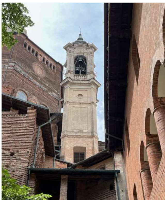
Fotografia n. 4 Vista del prospetto est del campanile.
