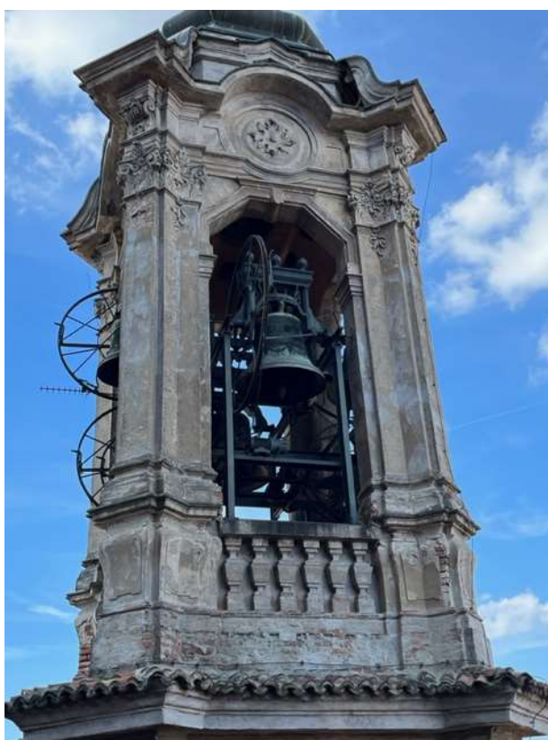
Fotografia n. 6 Dettaglio esterno della cella campanaria.
