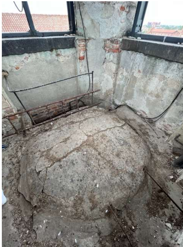
Fotografia n. 31 Vista interna: finitura in calcestruzzo pavimento cella campanaria
