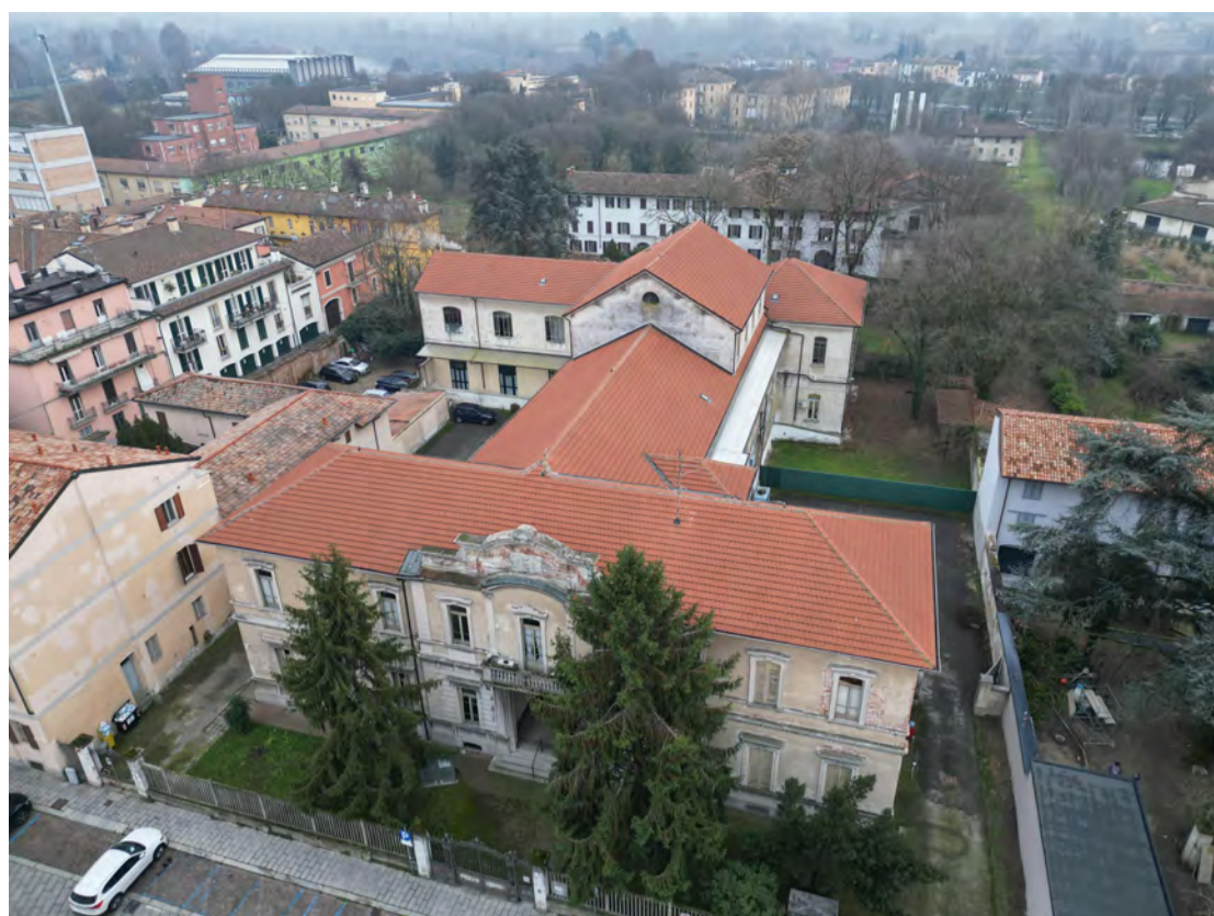
Vista aerea delle coperture fronte Nord
