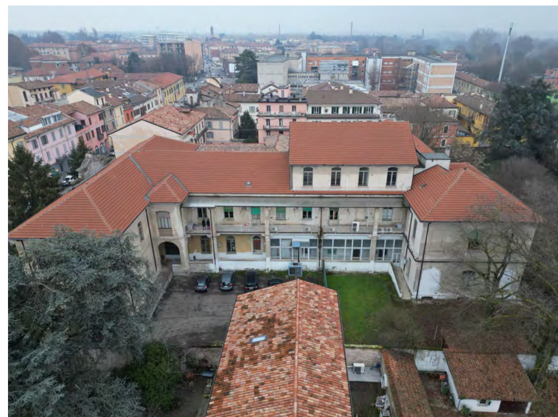
Vista aerea delle coperture fronte Ovest
