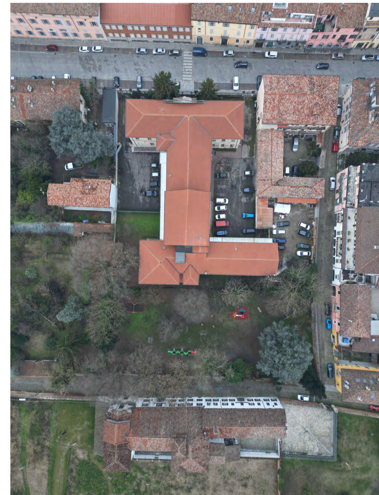
Vista aerea delle coperture
