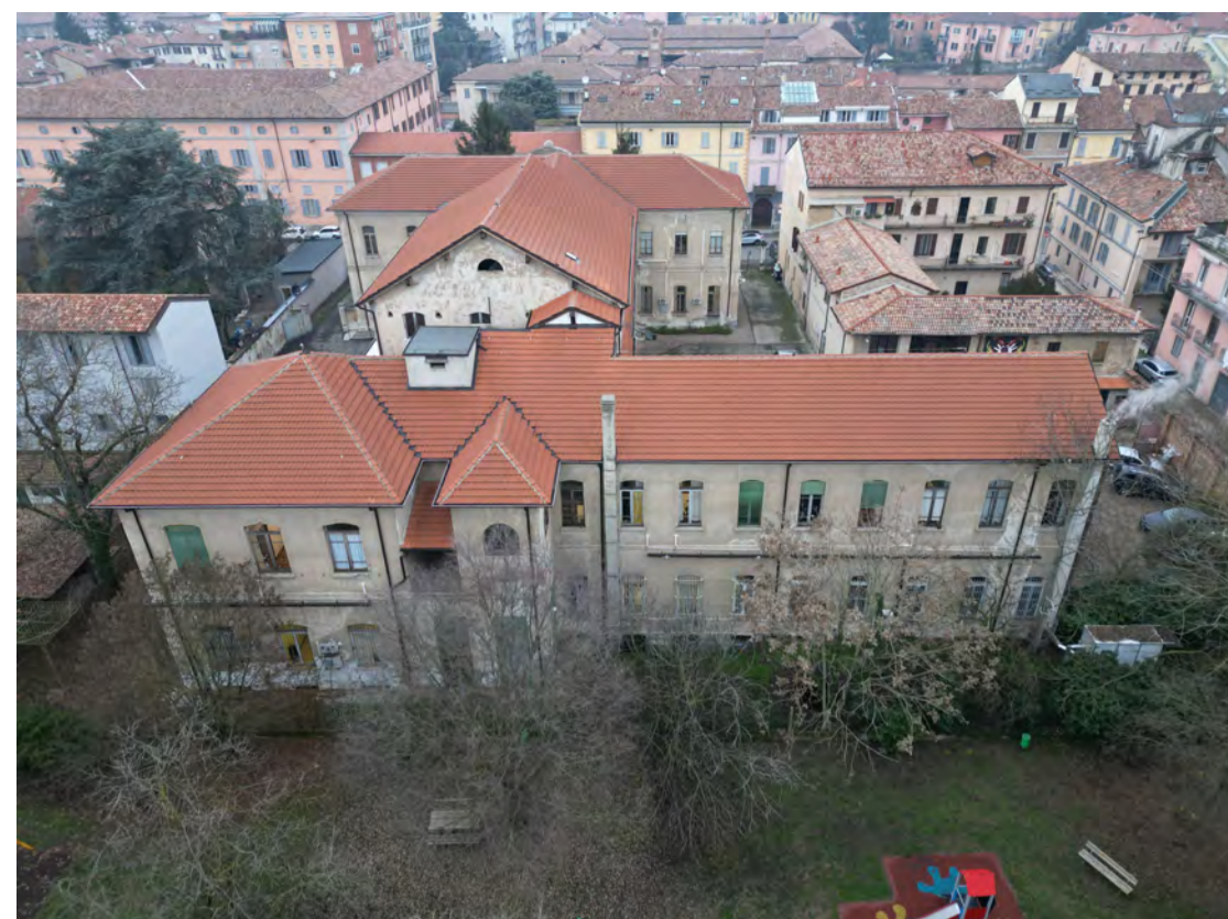
Vista aerea delle coperture fronte Sud
