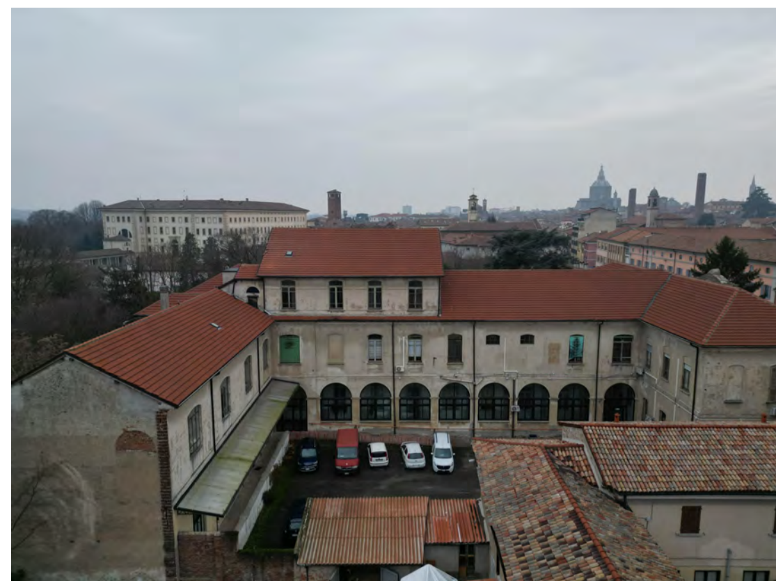
Vista aerea delle coperture fronte Est
