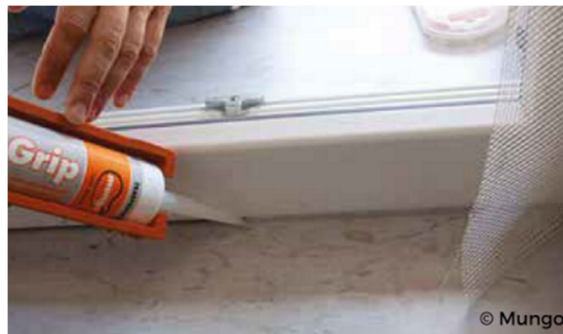
Figura n. 7: Esempio di sigillatura con silicone (Estratto catalogo società BigMat)
