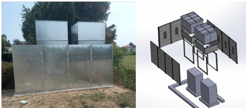
Figura n. 20: Vista del box isolante a titolo d'esempio realizzato per due PDC
