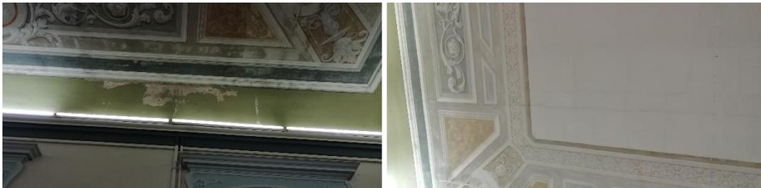
Descrizione danno: Fessurazione della controsoffittatura in cannicciato per deformazione del solaio ligneo.
