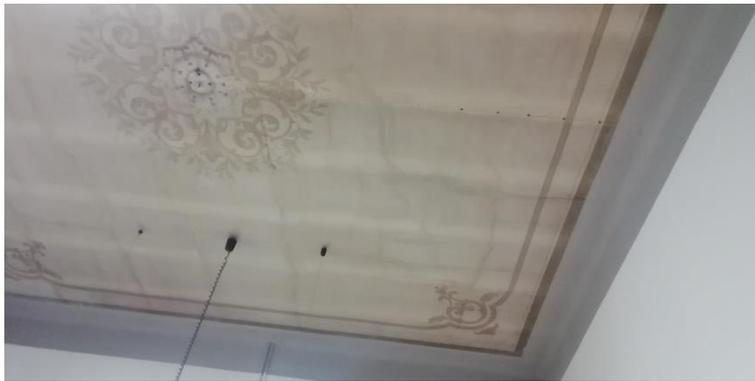
Descrizione danno: Fessurazione della controsoffittatura in canniciato per deformazione del solaio ligneo.
