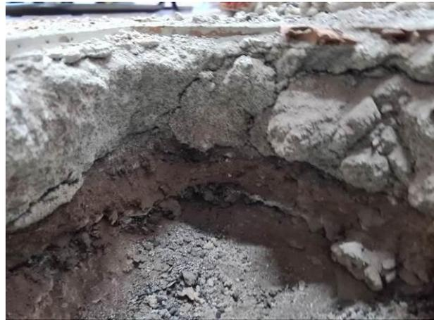
Solaio tipo As4 – Impalcato copertura piano terra
