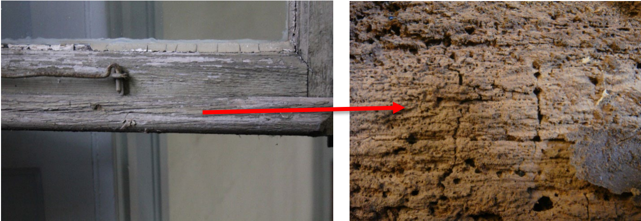
Particolare di un gocciolatoio, microfotografia con Dino Lite 300 x presenza di carie a cubetti con frattura perpendicolare alle fibre
