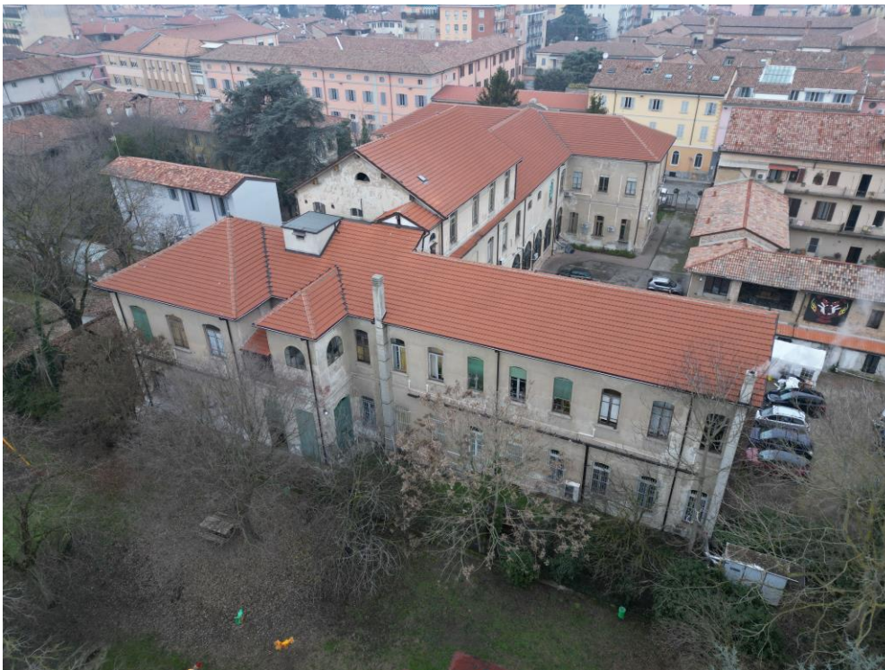
Figura 6 Vista aerea del fronte sud
