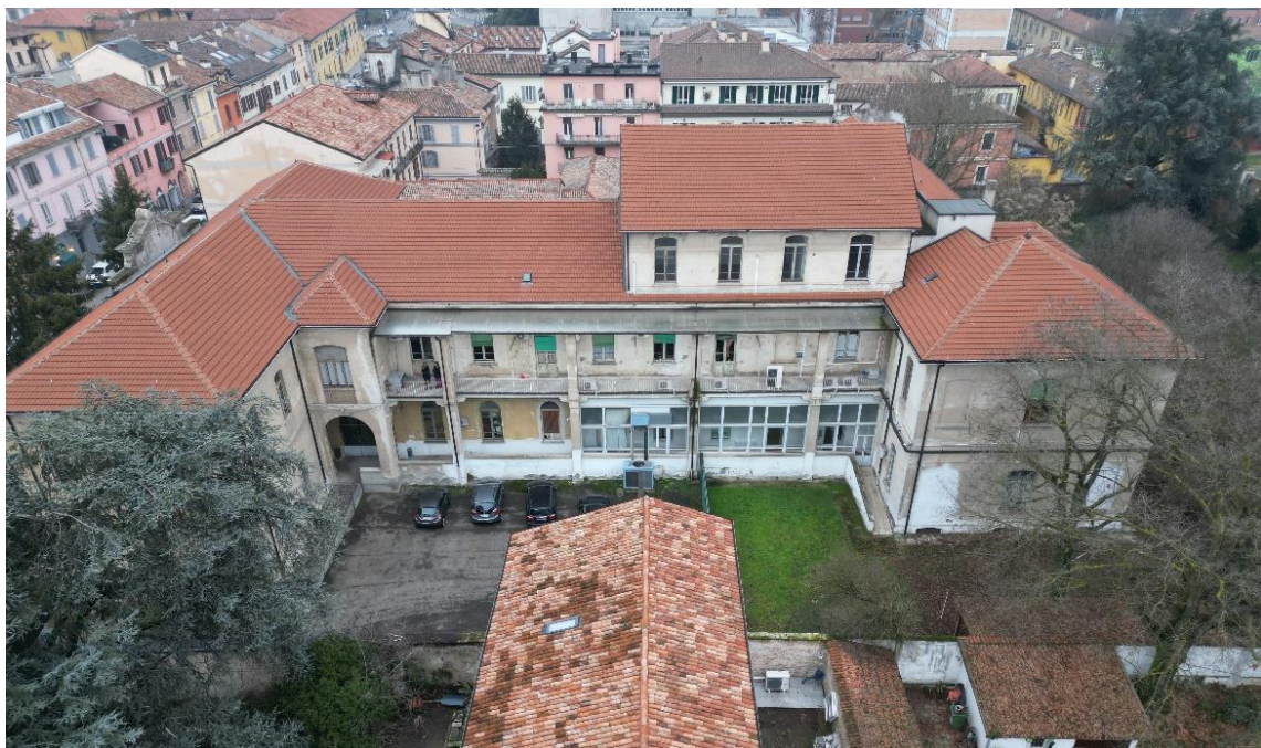
FOTO PROSPETTO OVEST
