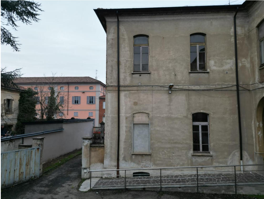
FOTO PROSPETTO SUD INTERNO
