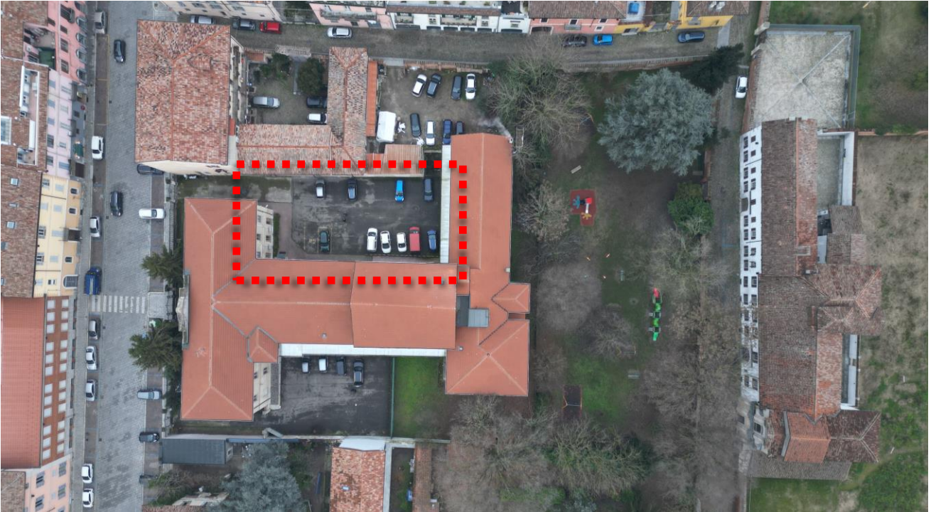
Figura 1 Foto aerea dell'area oggetto di intervento. In evidenza l'area cortilizia ad Est
