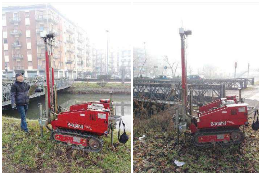
Esecuzione delle prove penetrometriche
