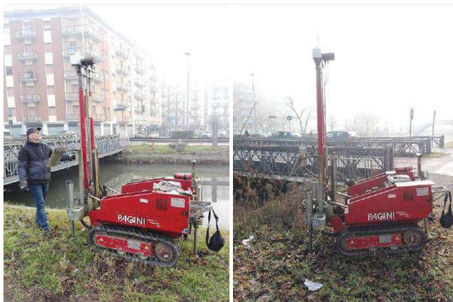
Esecuzione delle prove penetrometriche
