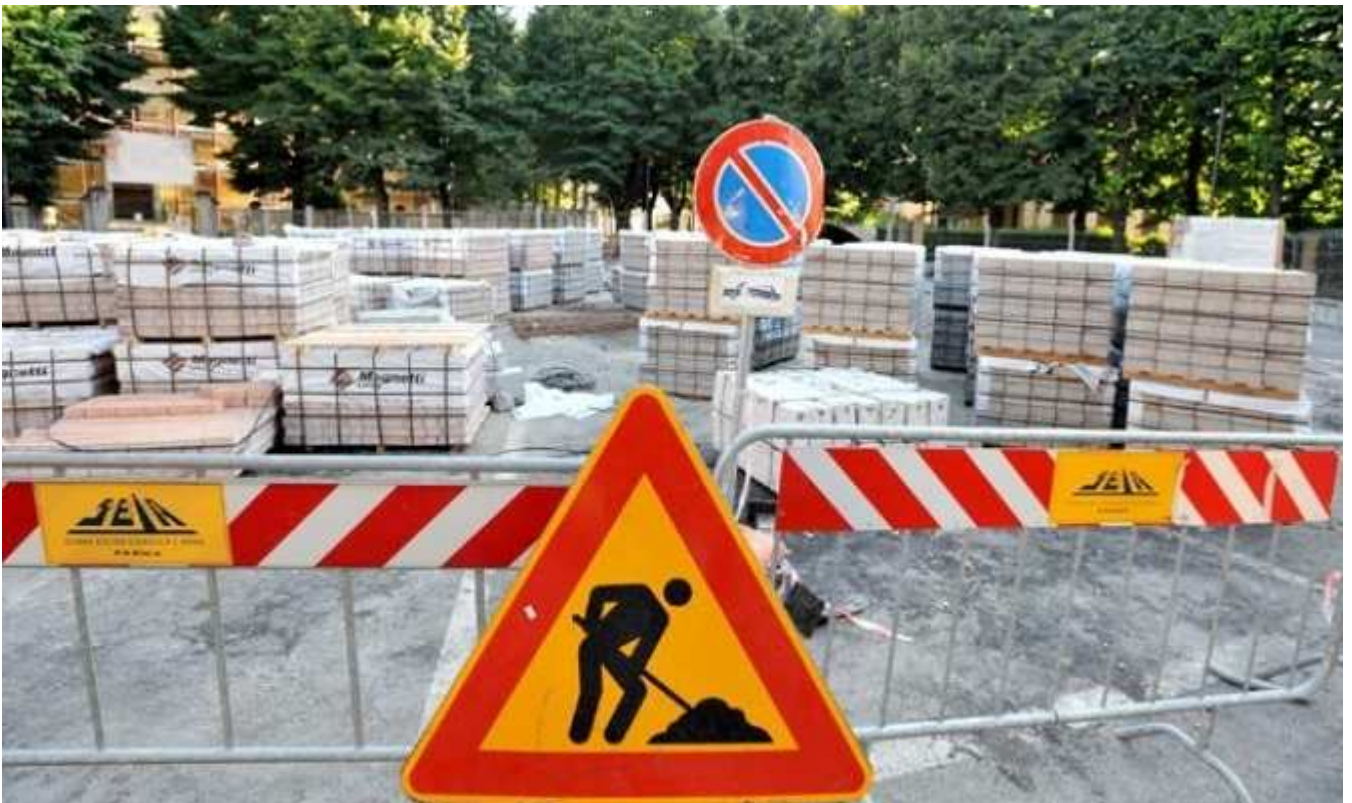
Esempi di delimitazione area di cantiere stradale.
