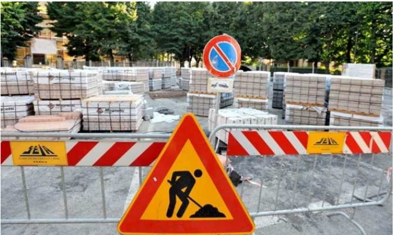
Esempi di delimitazione area di cantiere stradale.
