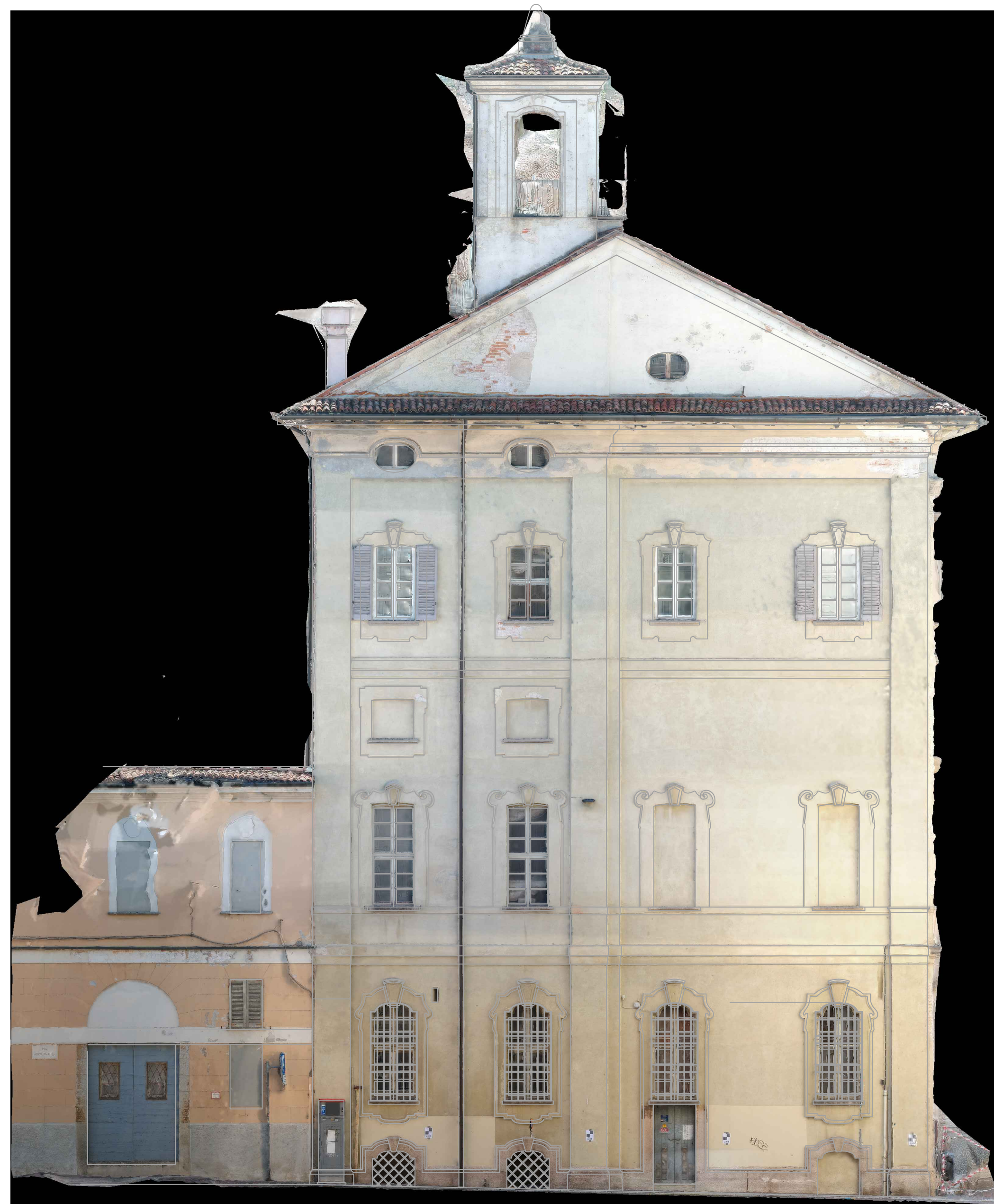
FRONTE LATERALE - via Foro Magno
