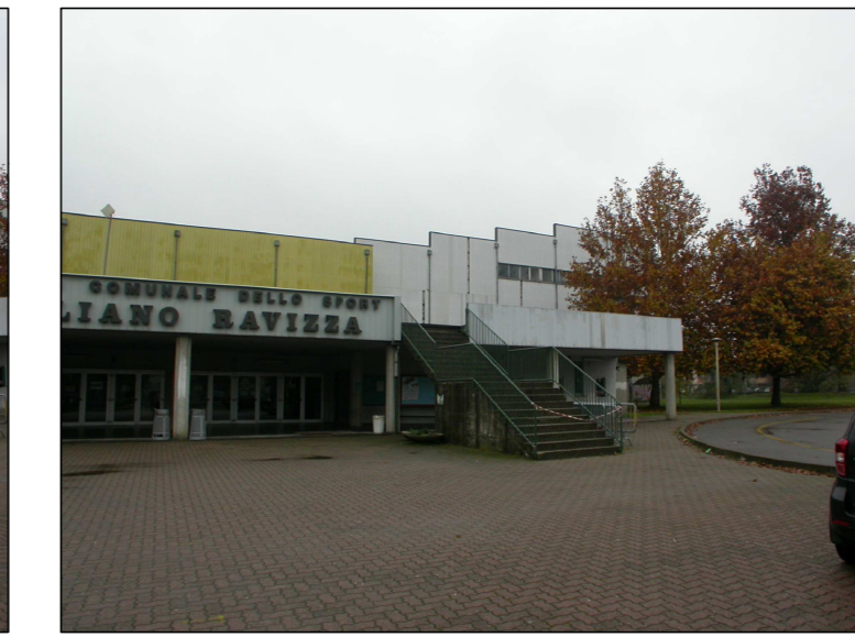
IMMAGINE n° 11 - PROSPETTO SUD-OVEST Scala SX di accesso alla Terrazza
