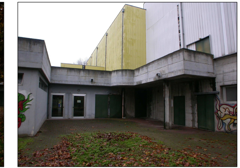
IMMAGINE n° 13 - PROSPETTO SUD-EST
