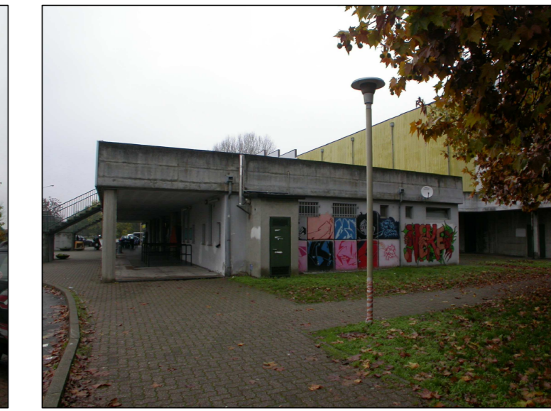
IMMAGINE n° 12 - PROSPETTO SUD-EST
