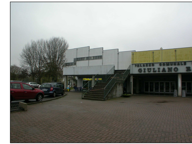
IMMAGINE n° 8 - PROSPETTO SUD-OVEST Scala DX di accesso alla Terrazza
