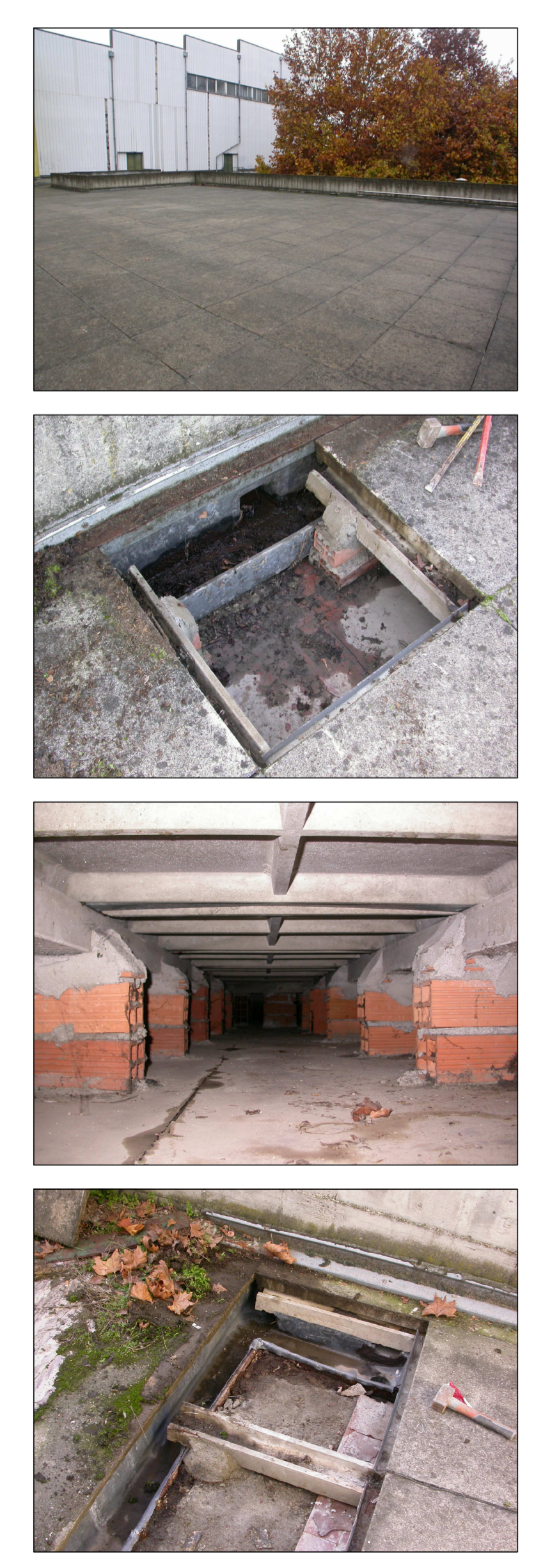
IMMAGINE n° 1 Pavimentazione sopraelevata in piastrelle di c.a.v. cm 70x70 (Cfr. PARTICOLARE "A") IMMAGINE n° 2 Profilo sagomato metallico di fissaggio a parete "banda del sole" Canale in lamiera zincata Bocchettone in lamiera zincata (Cfr. PARTICOLARE "A") IMMAGINE n° 3 Pavimentazione sopraelevata in piastrelle di c.a.v. cm 70x70 Canalina in c.a.v. per il convogliamento e lo smaltimento delle acque meteoriche Struttura puntuale di appoggio in mattoni forati di laterizio (Cfr. PARTICOLARE "A") IMMAGINE n° 4 Pavimentazione sopraelevata in piastrelle di c.a.v. cm 70x70 Canalina in c.a.v. per il convogliamento e lo smaltimento delle acque meteoriche Pavimentazione in piastrelle di gres Profilo sagomato metallico di fissaggio a parete "banda del sole" Canale in lamiera zincata Bocchettone in lamiera zincata (Cfr. PARTICOLARE "B")
