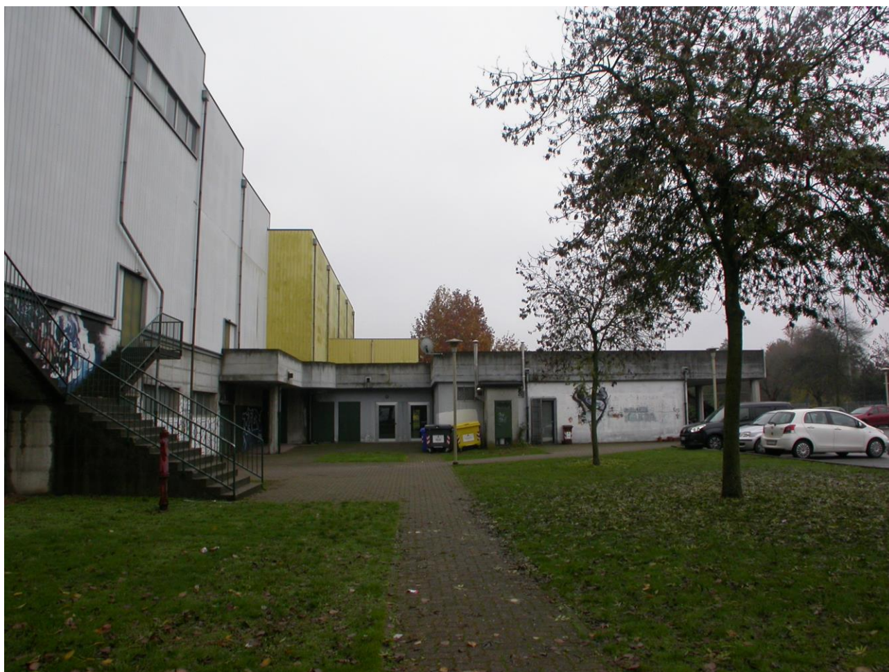
Foto n° 2 – PROSPETTO NORD-OVEST - Terrazza
