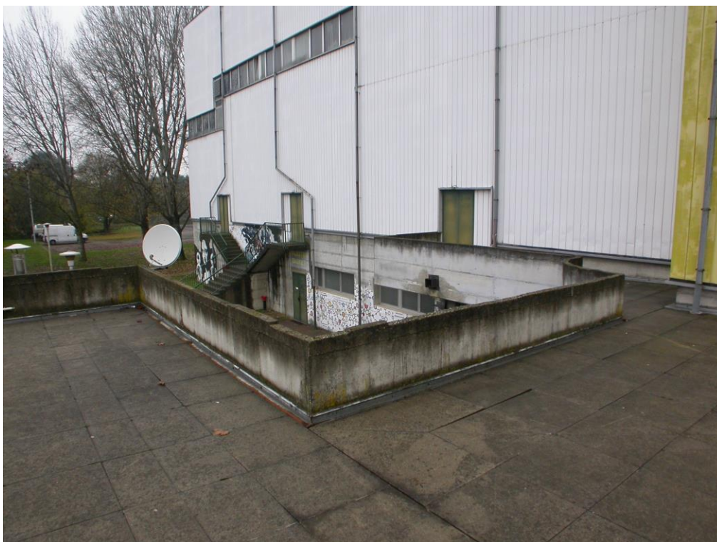
Foto n° 29 – Terrazza - vista verso l'uscita di sicurezza a NORD-OVEST
