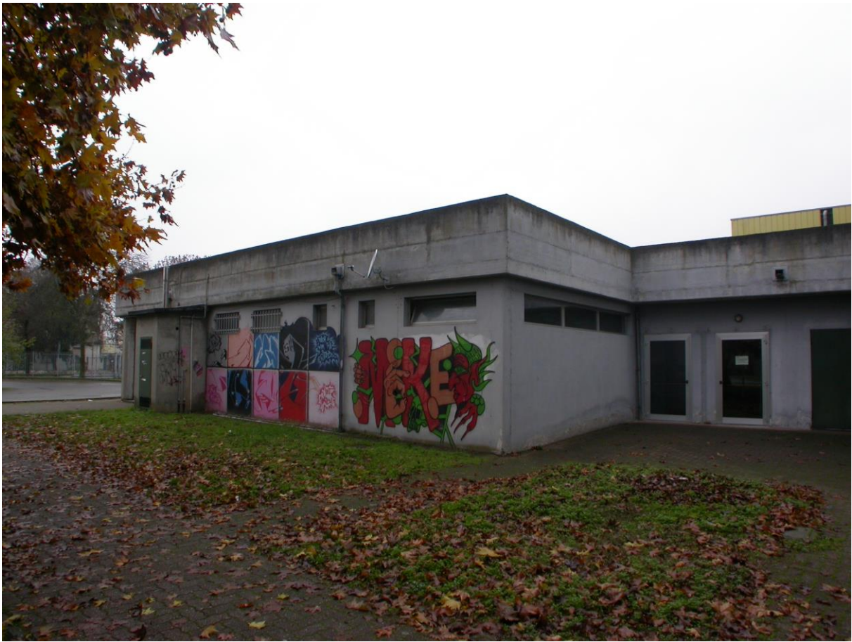
Foto n° 11 – PROSPETTO SUD-EST - part.
