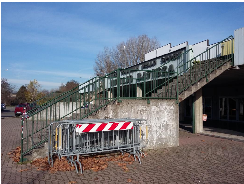
Foto n° 23 – Scala di sicurezza "B" (Sx) - vista laterale (Sud-Est)
