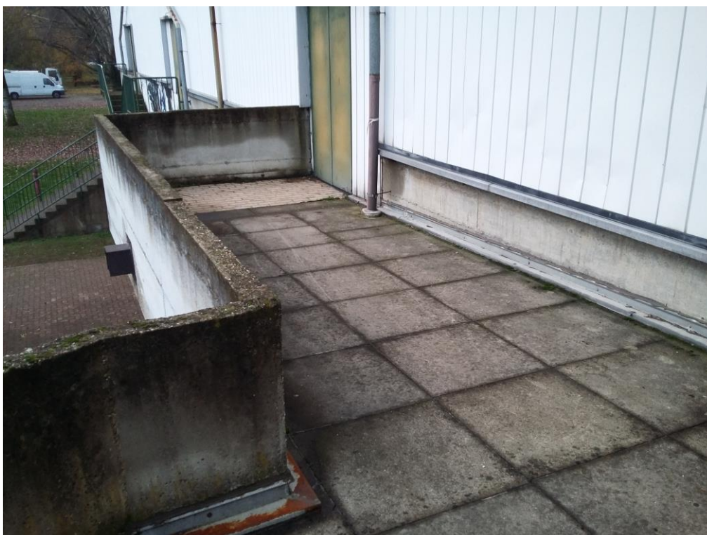
Foto n° 30 – Terrazza – vista dell'uscita di sicurezza a NORD-OVEST
