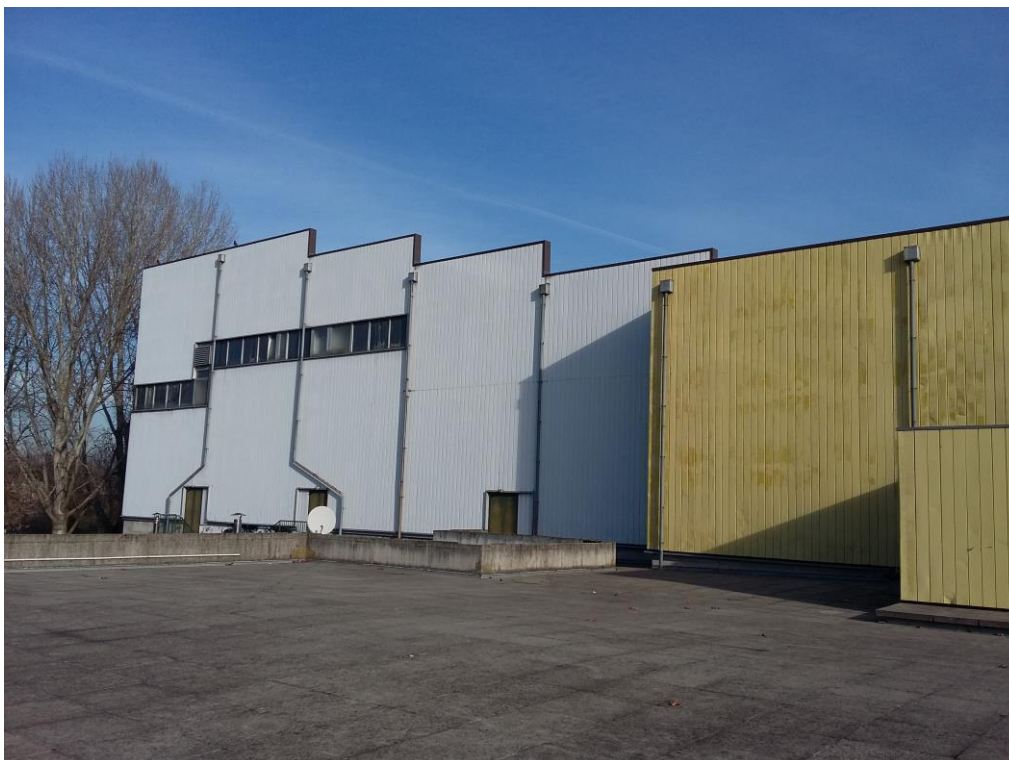
Foto n° 28 – Terrazza - vista verso il lato NORD-OVEST
