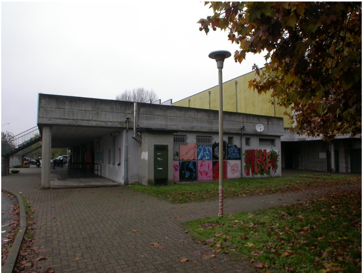
Foto n° 10 – PROSPETTO SUD-EST - part.
