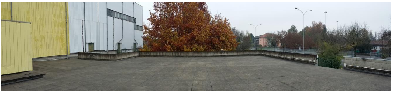
Foto n° 32 – Terrazza - vista lato SUD-EST
