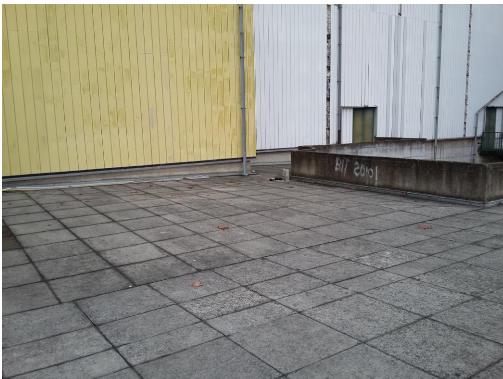
Foto n° 35 – Terrazza - vista verso l'uscita di sicurezza a SUD-EST
