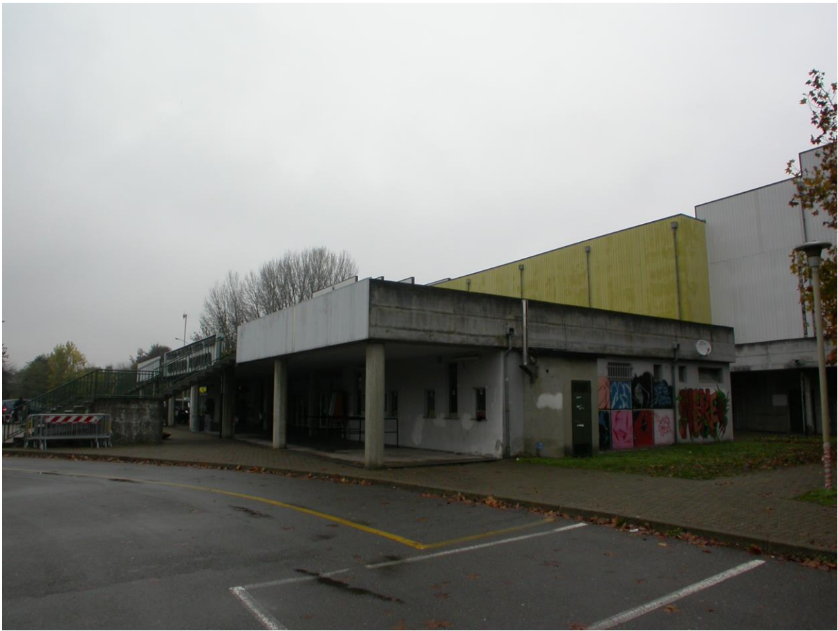
Foto n° 9 – PROSPETTO angolo SUD-OVEST - SUD-EST
