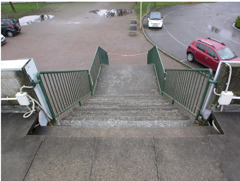
Foto n° 25 – Terrazza - vista verso la scala di sicurezza “A” (Dx)
