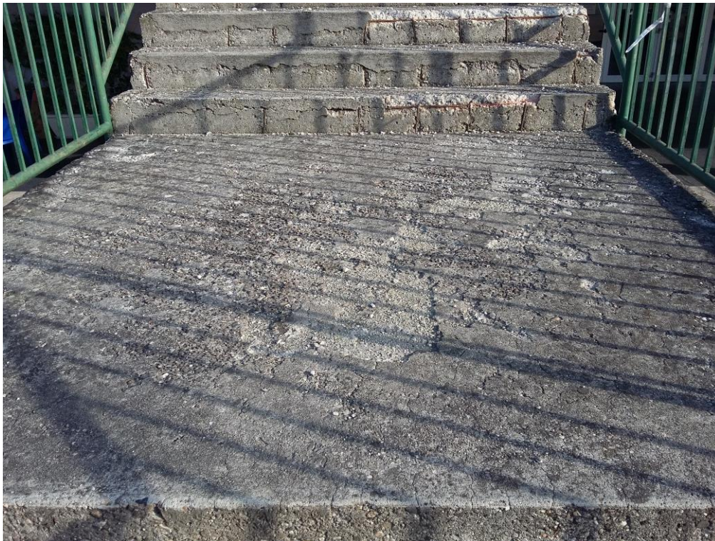
Foto n° 15 – Scala di sicurezza "A" (Dx) - pianerottolo intermedio
