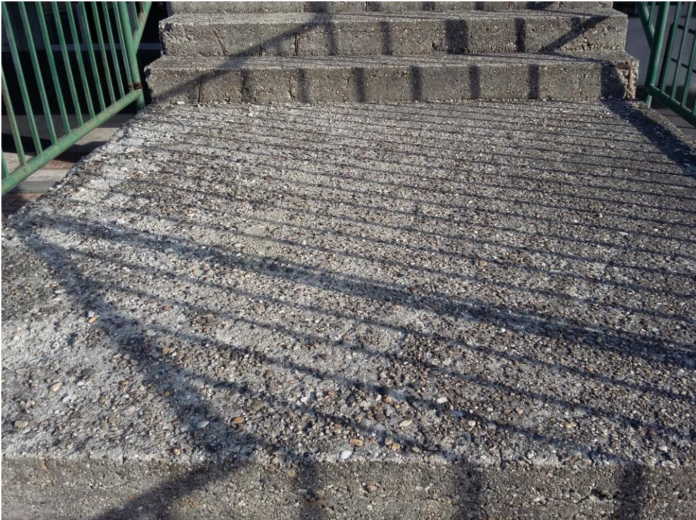
Foto n° 21 – Scala di sicurezza "B" (Sx) - pianerottolo intermedio
