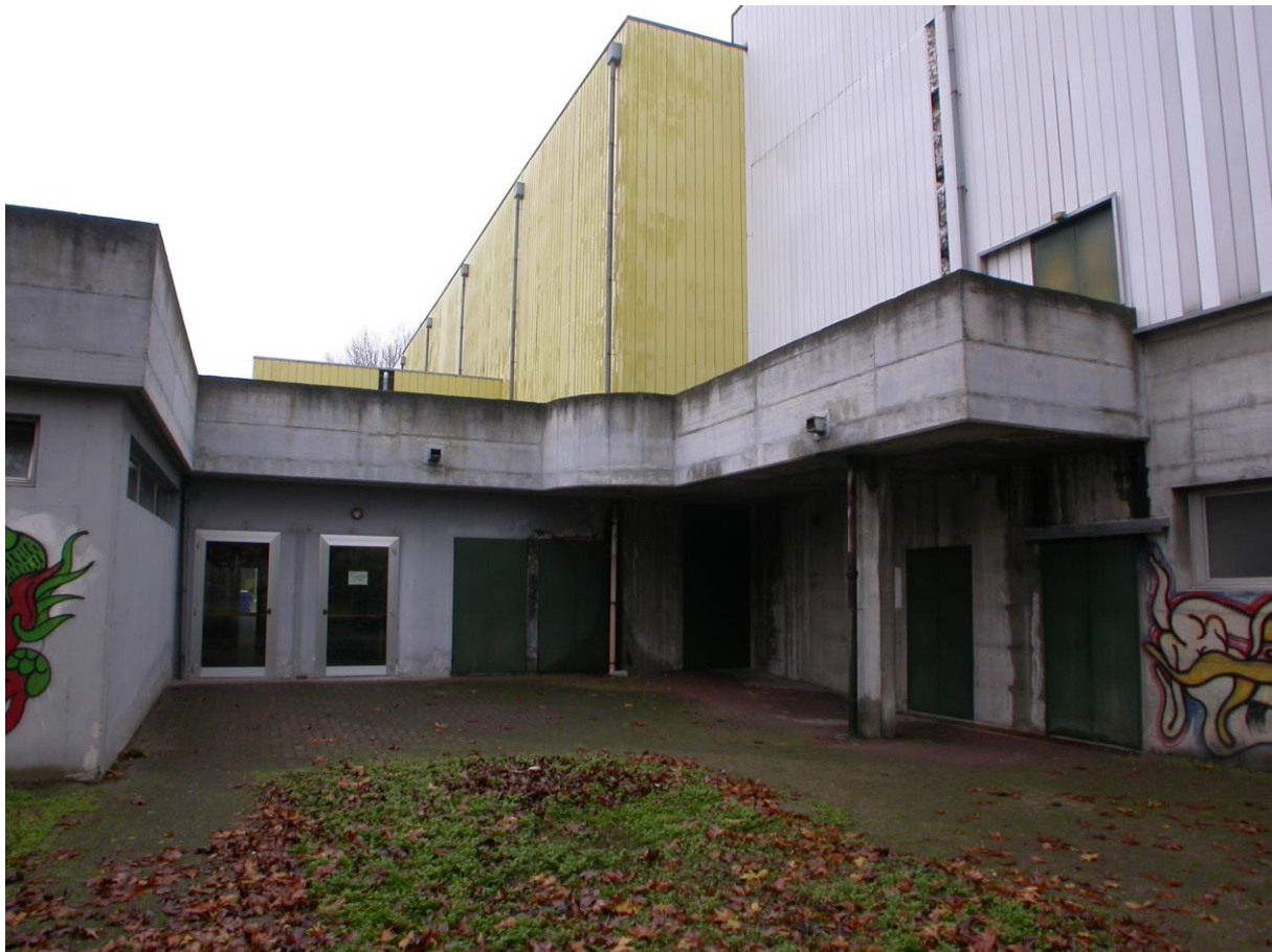
Foto n° 12 – PROSPETTO SUD-EST - part. collegamento Terrazza/Palazzetto
