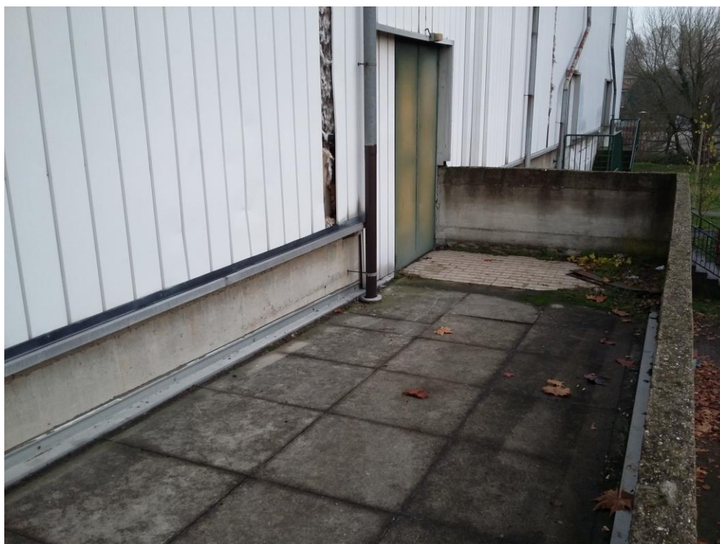
Foto n° 36 – Terrazza – vista dell'uscita di sicurezza a SUD-EST
