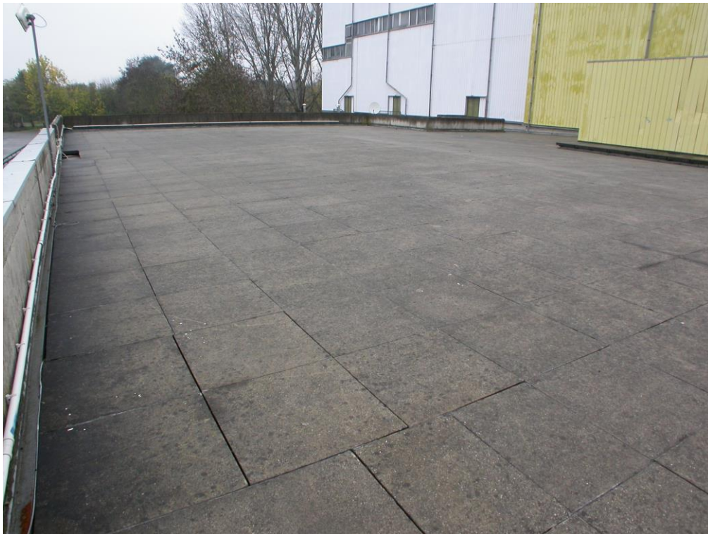
Foto n° 27 – Terrazza - vista verso il lato NORD-OVEST
