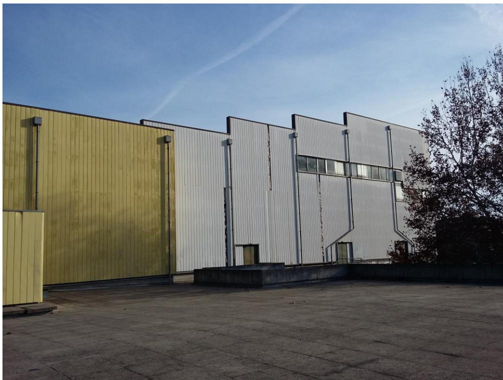
Foto n° 34 – Terrazza - vista verso il lato SUD-EST
