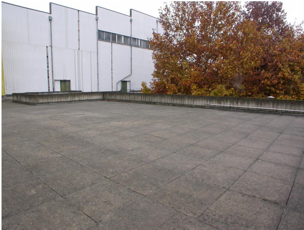
Foto n° 33 – Terrazza - vista verso il lato SUD-EST
