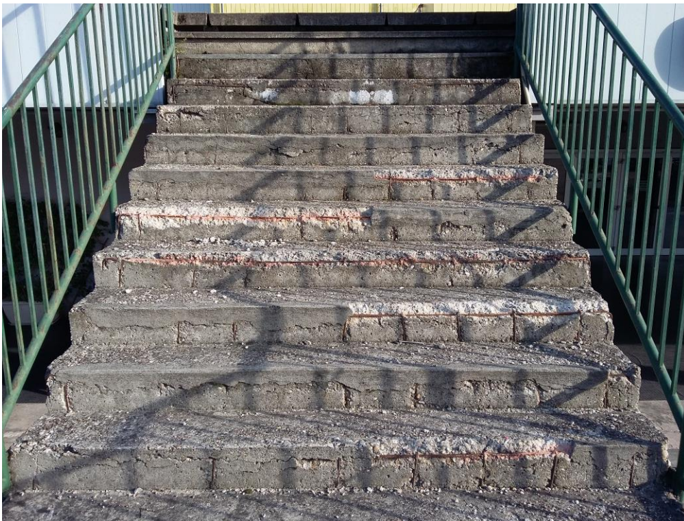
Foto n° 16 – Scala di sicurezza "A" (Dx) - gradini superiori
