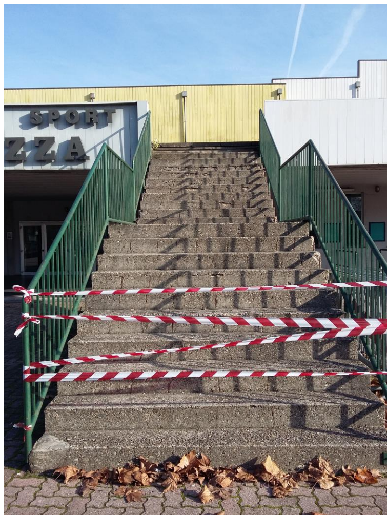
Foto n° 19 – Scala di sicurezza "B" (Sx) - vista frontale
