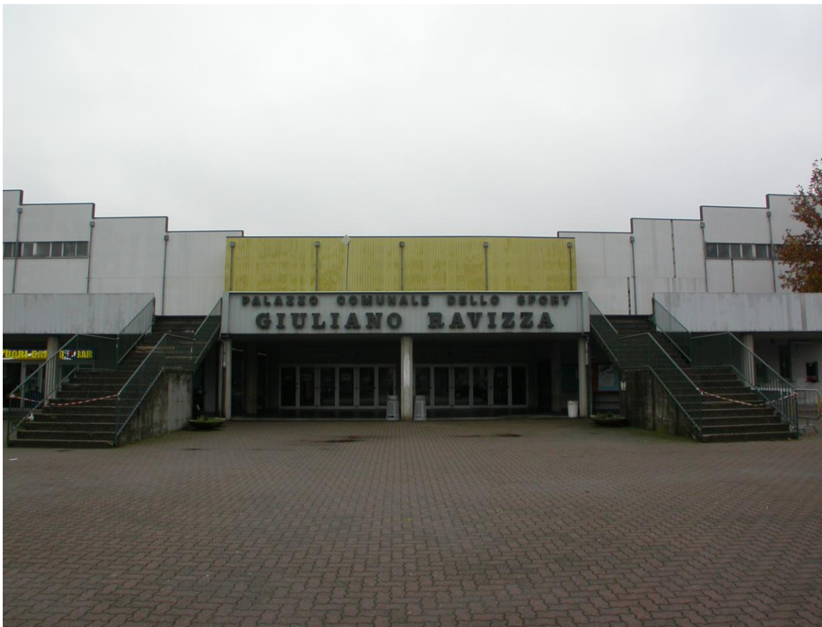
Foto n° 7 – PROSPETTO SUD-OVEST – Accesso principale al Palazzetto dello sport
