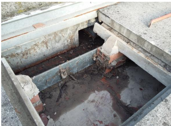
Piastrelloni, canali e pavimentazione originaria in gres
