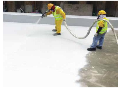
Esempio di impermeabilizzazione di coperture
