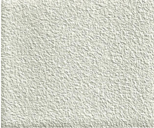
Impermeabilizzazione con “membrana a base di poliurea pura bicomponente”
