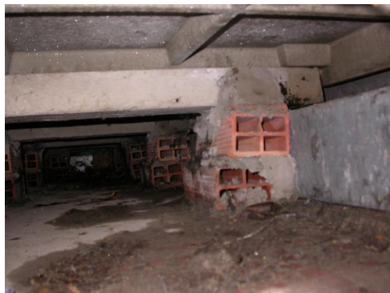
Intradosso dei piastrelloni, canali e pavimentazione originaria in gres
