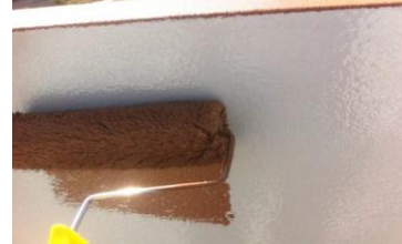
Esempio di impermeabilizzazione di parapetti
