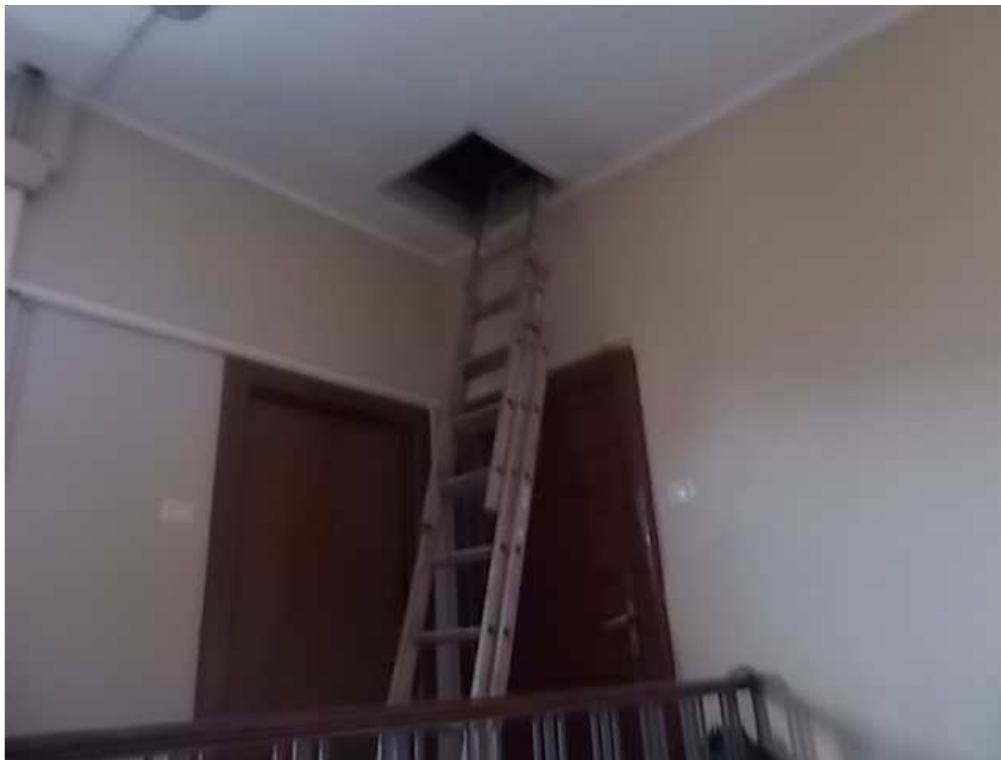
Foto 9 - Particolare accesso al sottotetto
