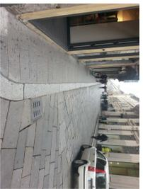
I marciapiedi in questo tratto sono realizzati in lastre di granito bocciardato; per via del loro importante spessore (8 cm), non necessitano attualmente di manutenzione. La strada appare caratterizzata da un forte predominio del colore grigio. Il progetto prevede di riprendere la finitura di tali marciapiedi (in lastre di granito) anche nel tratto a sud di Via Varese, fino a Piazzale Ponte Coperto, uniformando in questo modo tutta la pavimentazione dei marciapiedi in Strada Nuova
