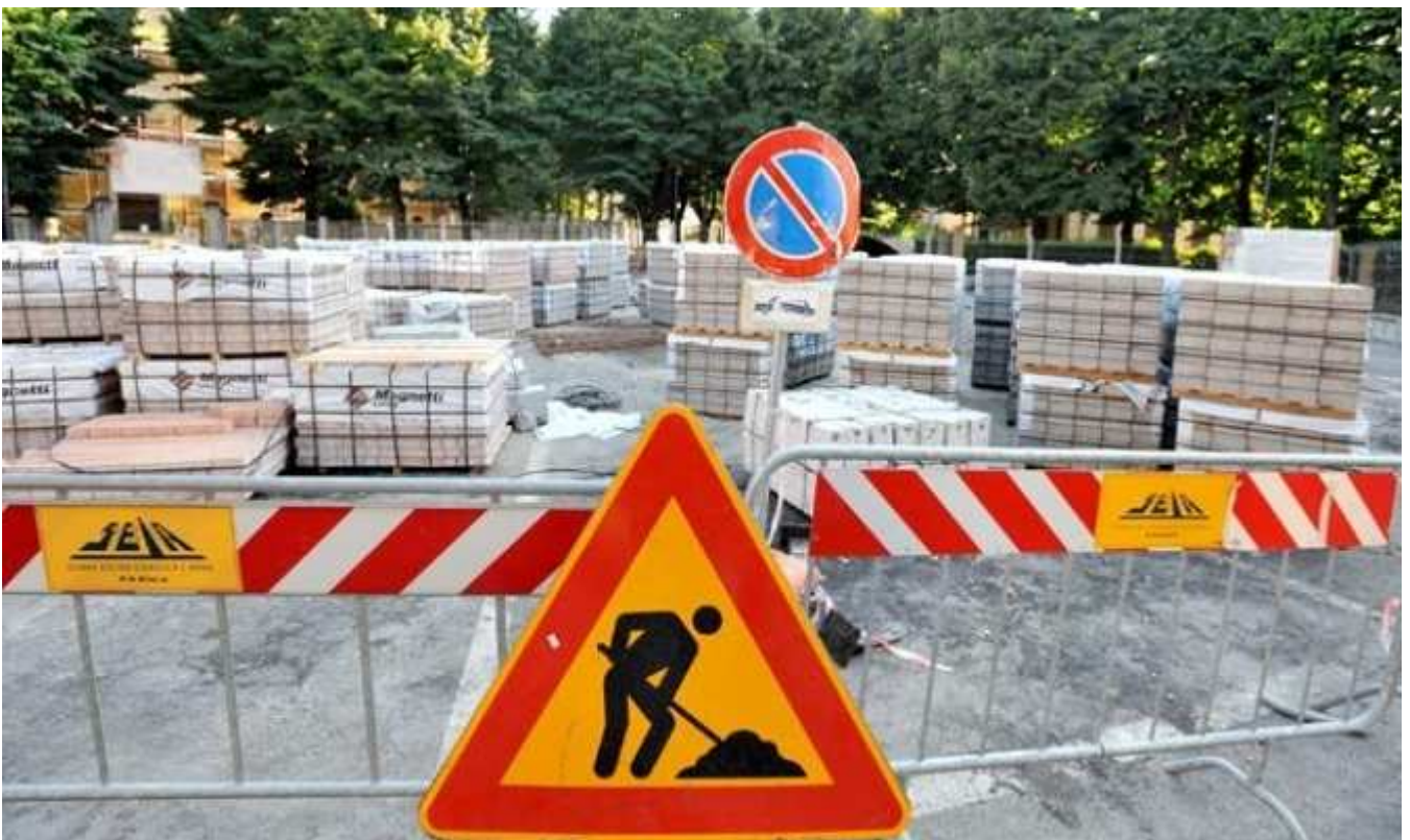
Esempi di delimitazione area di cantiere stradale.
