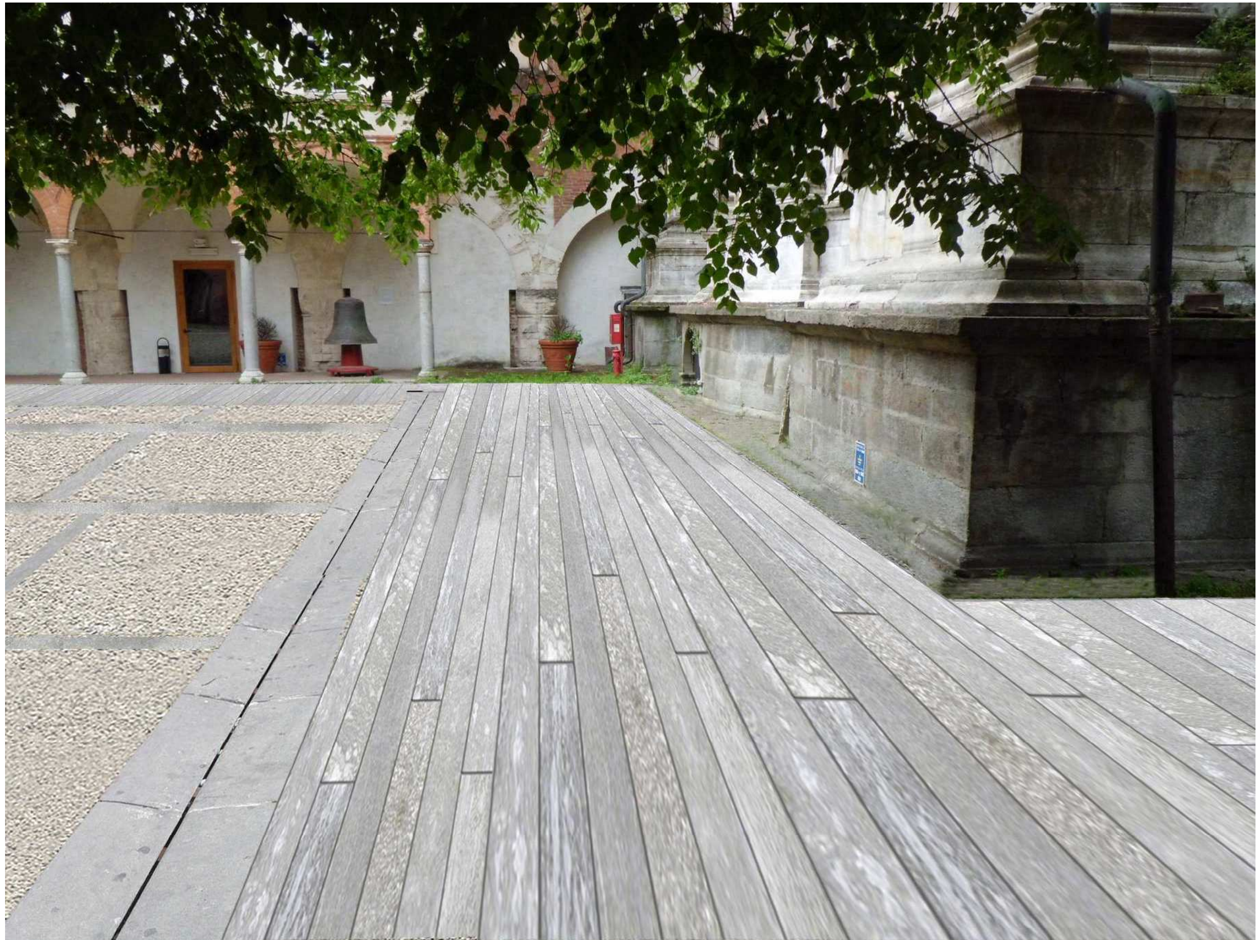
Particolare della caditoia di raccolta acque in lastre di pietra sagomate, taglio centrale e tozzetti in pietra, a delimitare la porzione in pietra a correre
